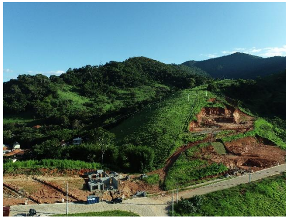
Foto D3: Direção sudoeste, vista de cortes no talude para construção de um loteamento.
