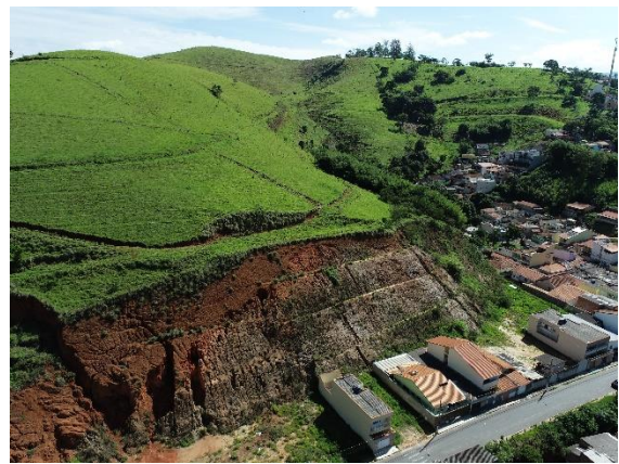
Foto E2: Direção nordeste, morro no Bairro Vila Isabel, à direita da área instabilizada.
