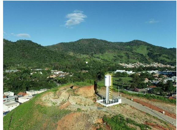
Foto D2: Direção sudeste, vista de uma instalação de reservatório no alto do morro para abastecimento de água do loteamento em construção.
