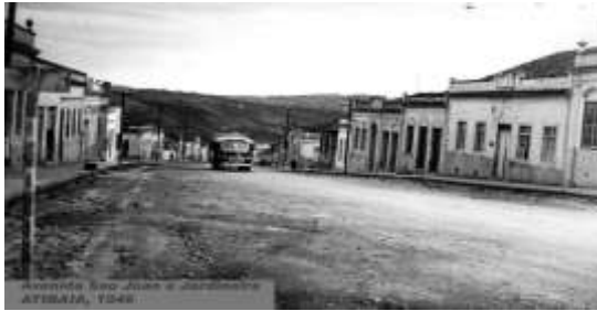
Imagem 22: Avenida São João 1946.
