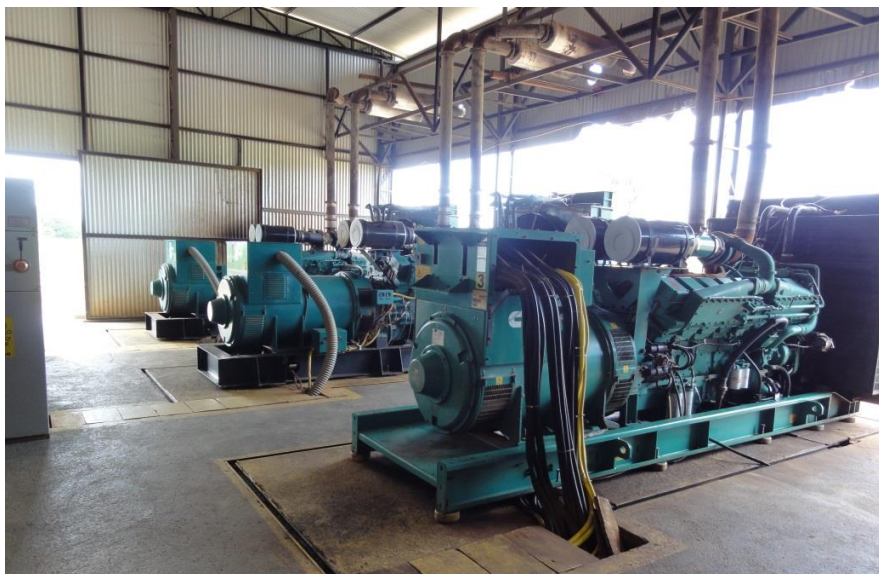
Figura 2-21 Casa de máquinas da UTE Triunfo em Rondônia
