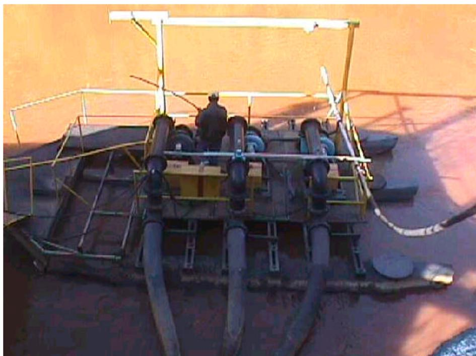
**Figura 6.1 – Foto Ilustrativa das Bombas de Captação de Água do Rio Sapucaí – Captação Santa Rosa – Itajubá/MG.**
