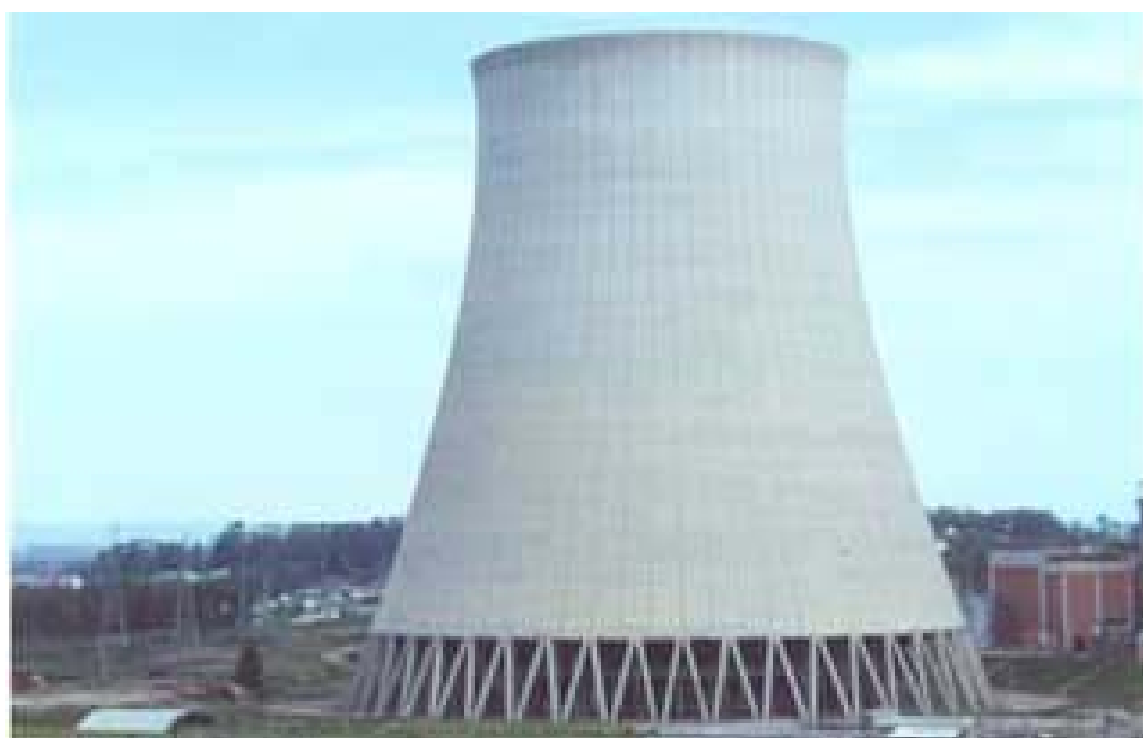
Figura 2.80: Torre de resfriamento seca da UTE Presidente Médici no Rio Grande do Sul. Fonte: Companhia de Geração Térmica de Energia Elétrica (2000).
