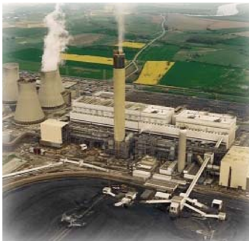
Figura 5.4: Vista aérea do depósito de carvão. Fonte: Cleveland Bridge (2004).
