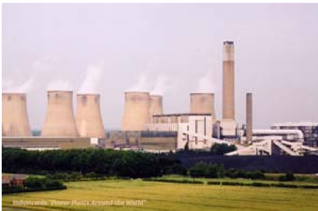
Figura 2.83: Torres de resfriamento úmidas do complexo Ratcliffe. Fonte; industcards (2004).
