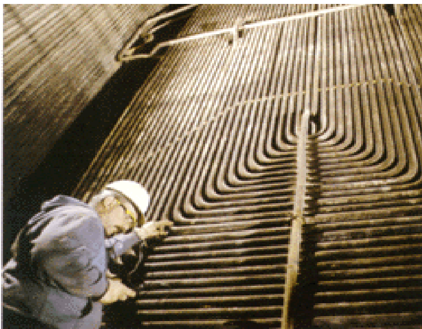
Figura 2.33: Superaquecedor radiante tipo placa (platen) de uma grande caldeira sendo inspecionado. Fonte: Babcock Power Inc. (2003).
