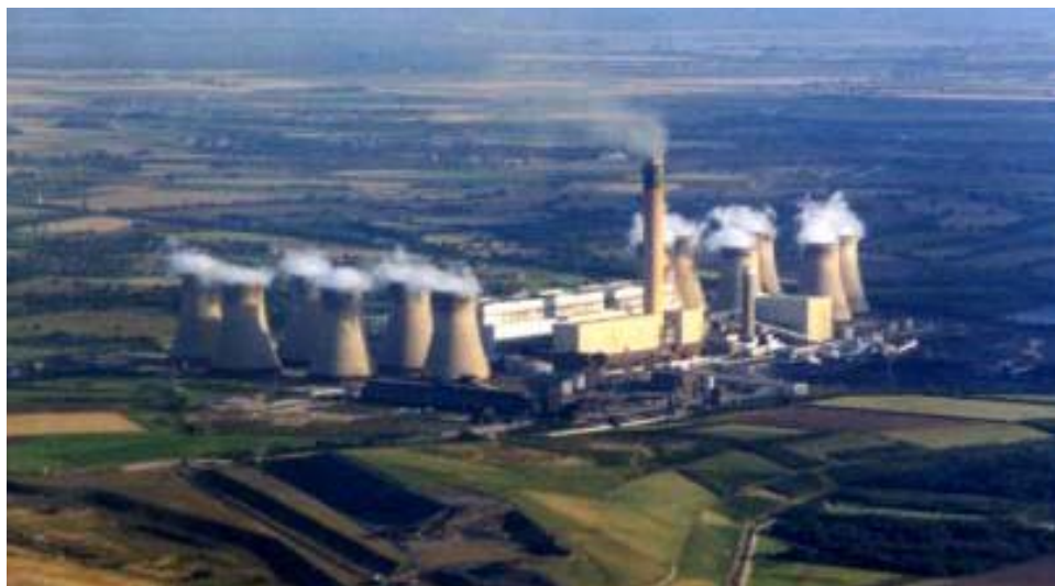
Figura 5.1: Vista aérea do complexo Drax na Inglaterra. Fonte: Fonte: AES Drax Power Ltd (2002).
