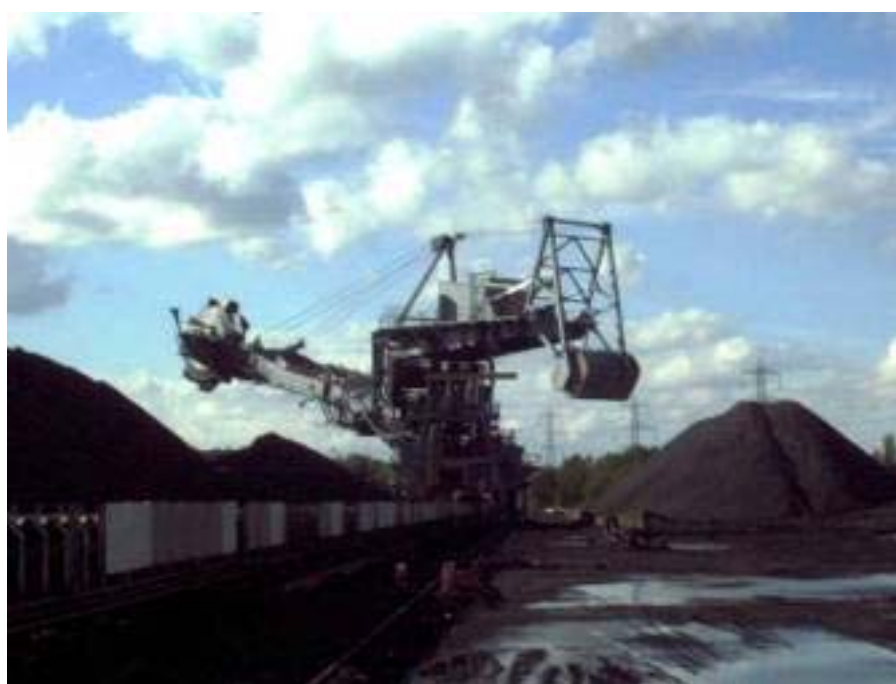
Figura 5.21: Foto do depósito de carvão e da máquina de manipulação. Fonte: AES Drax Power Ltd (2002).
