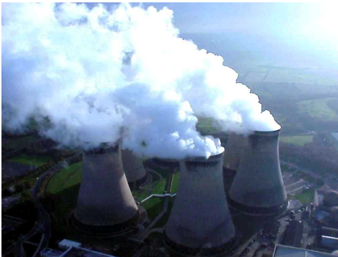
Figura 5.12: Foto aérea das torres de resfriamento úmidas de Drax. Fonte: AES Drax Power Ltd (2002).
