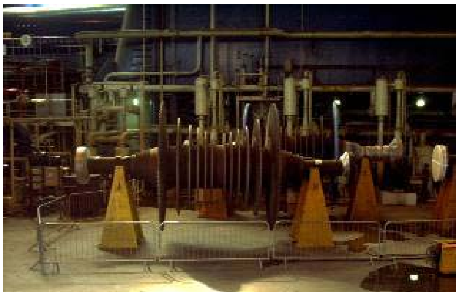
Figura 5.9: Foto do rotor de uma turbina de baixa pressão removido para reparos. Fonte: AES Drax Power Ltd (2002).
