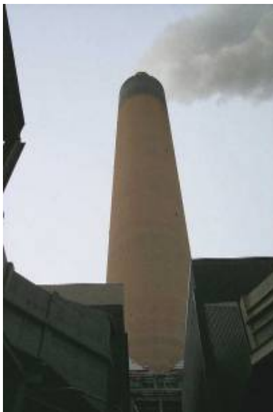
Figura 5.18: Foto da chaminé principal de Drax. Fonte: AES Drax Power Ltd (2002).
