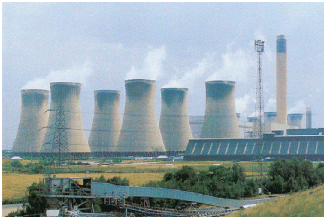
Figura 5.3: Vista das plumas geradas nas torres de resfriamento e a chaminé principal. Fonte: Munters UK (2003) .
