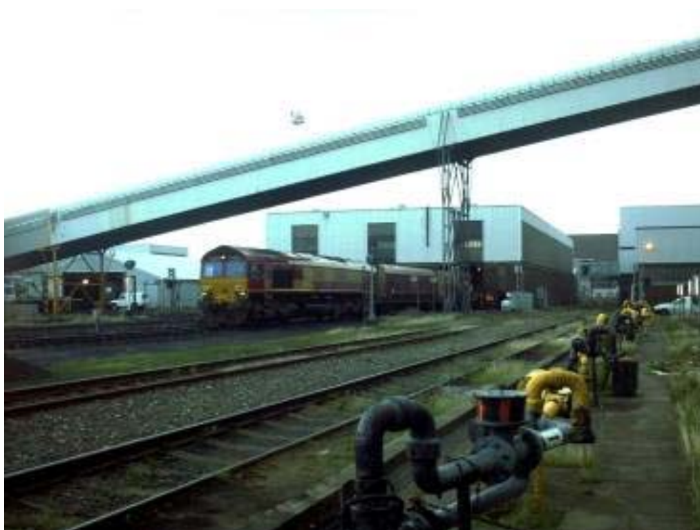
Figura 5.20: Foto da casa de descarga automática do carvão dos vagões dos trens. Fonte: AES Drax Power Ltd (2002).
