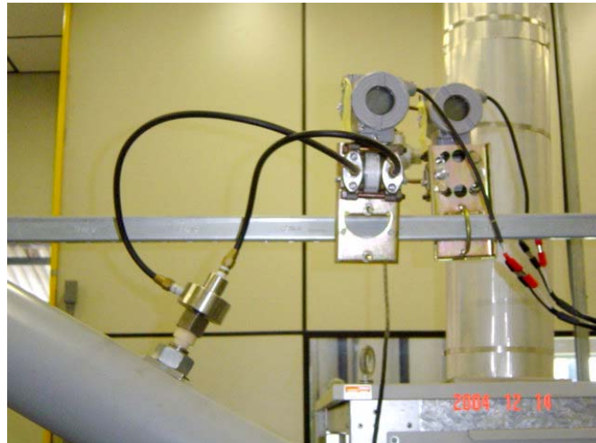
Figura 5.3 - Medição de vazão de ar
