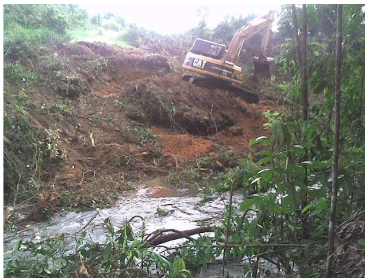
Figura 5.8 – Início da limpeza da área da barragem e chegada da estrada de acesso.
