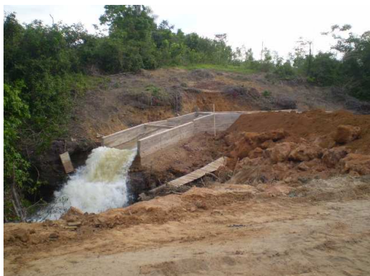
Figura 5.10 – Barragem em fase final, com a água já passando pelo vertedouro.
