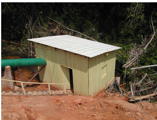
Figura 5.14 – Vista da casa de máquinas
