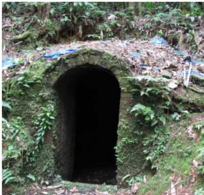
Figura 2.5 – Forno de encosta (Oliveira, 2009)
