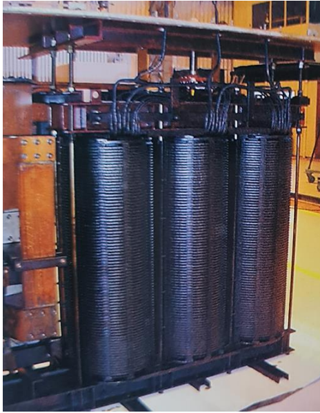
Figura 14 – Imagem de bobina com papel isolante degradado
