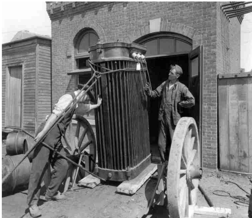
Figura 1 – Imagem de um dos primeiros transformadores do século XIX
