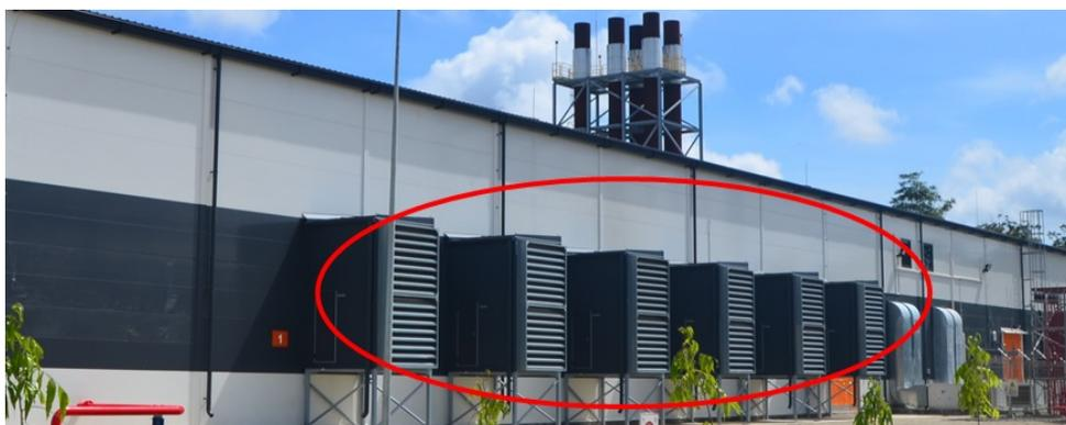
Figura 3 – Exemplo das entradas de ar para refrigerar o ambiente da casa de máquinas (3).
