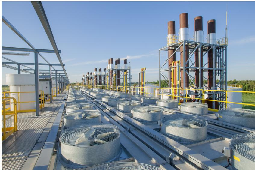
Figura 6 – Exemplo de disposição dos radiadores (6).
