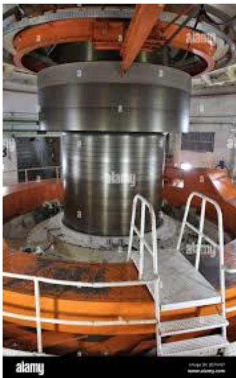
(a) Eixo inferior da turbina
