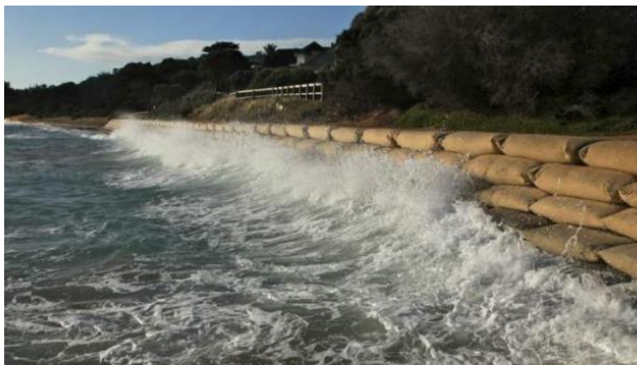
Figura 36: Terra ensacada para controle de erosão.
