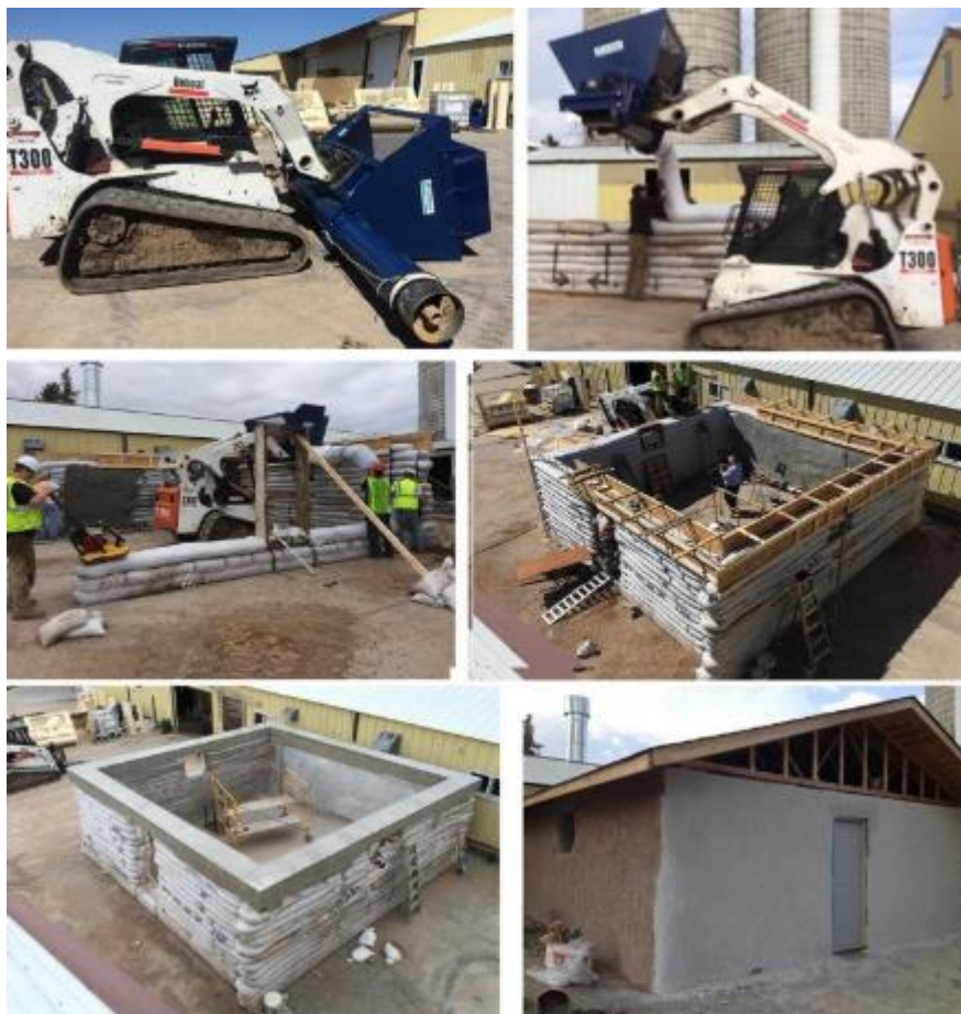
Figura 53: Terra ensacada mecanizada.
