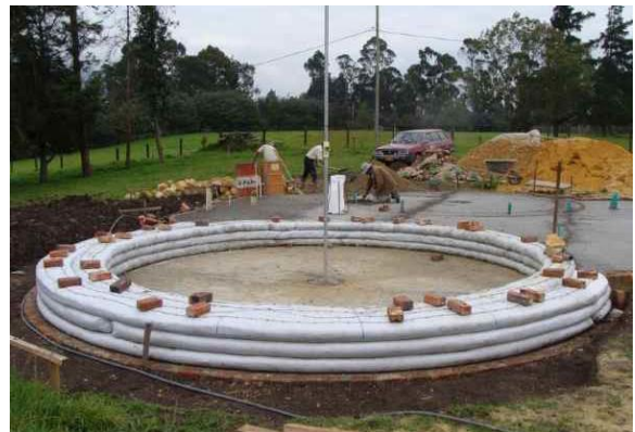
Figura 44: Sobreposição de fiadas com aplicação de arame farpado.
