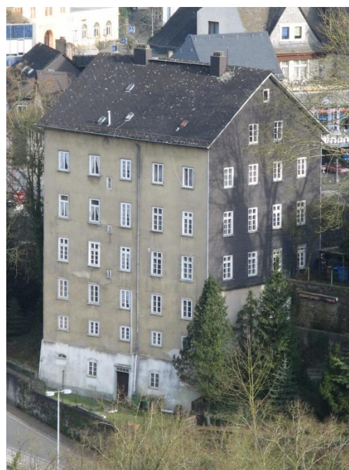
Figura 16: Haus Rath, edifício de sete andares em taipa de pilão com terra não estabilizada, Weilburg, Alemanha, 1828
