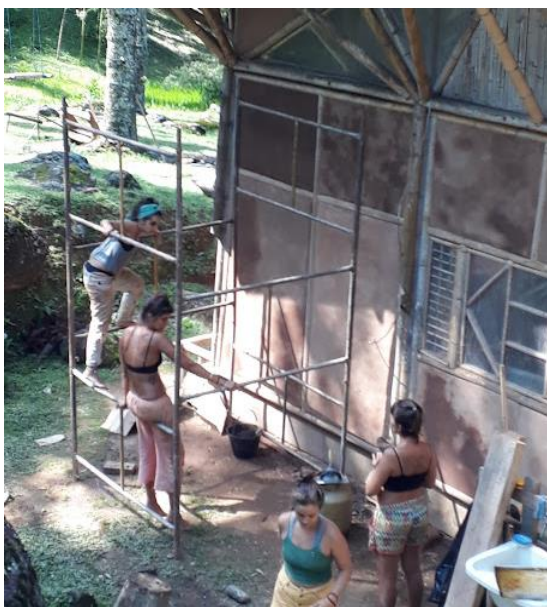
Figura 89: Mulheres preparando andaimes para aplicação de reboco externo.
