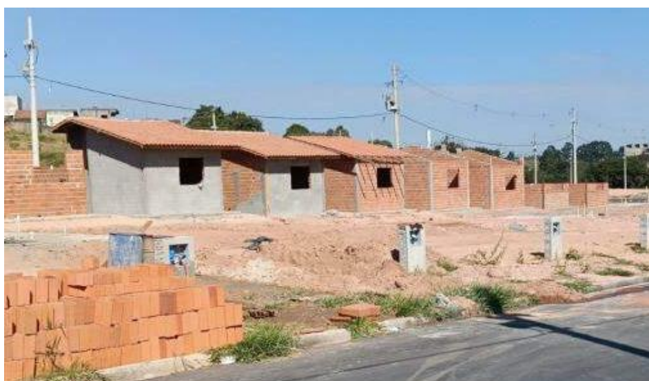
Figura 60: Casas-embriões em construção, Campinas – SP, 2023.
