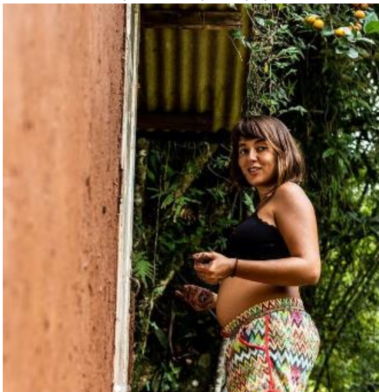
Figura 87: Mulher grávida aplicando reboco de terra em parede de pau a pique.
