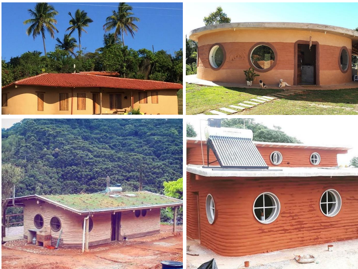
Figura 47: Exemplos de residências construídas em Hiperadobe no Brasil, e suas possibilidades: paredes curvas ou retas, acabamento liso ou com textura das fiadas.
