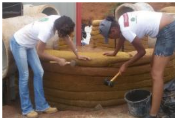
Figura 52: Compactação lateral das fiadas de Hiperadobe com martelos de borracha.
