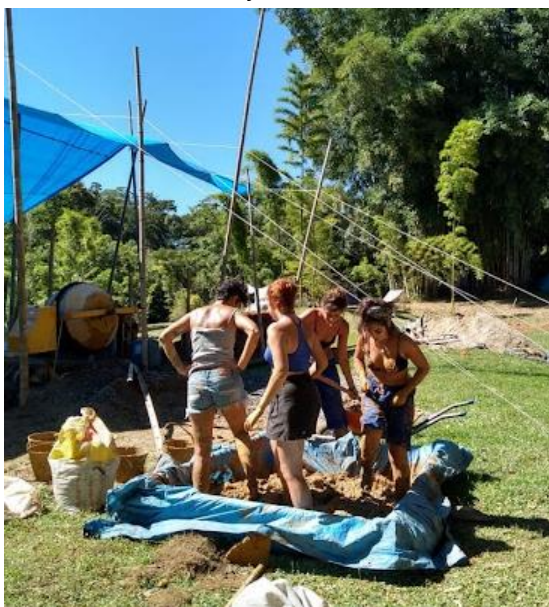
Figura 90: Mulheres preparando massa para fabricação de adobe.
