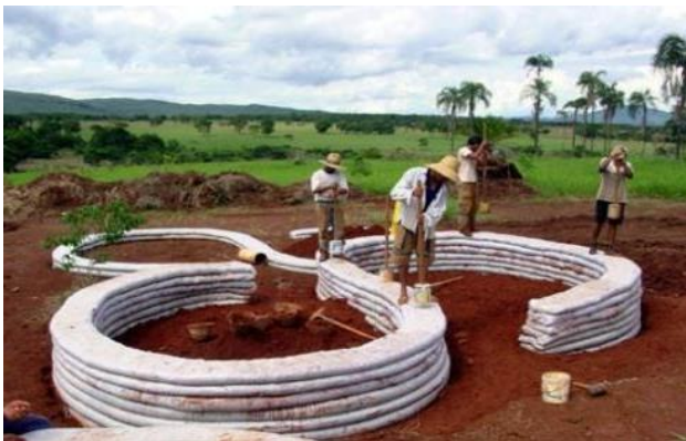
Figura 43: Compactação da fiada com pilão manual.
