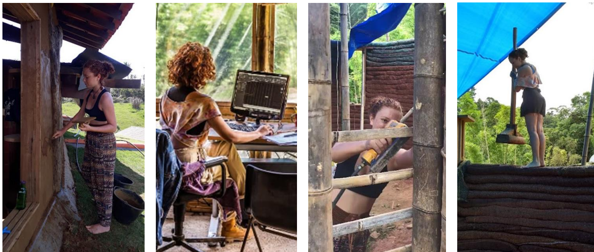
Figura 80: Exemplos de experiência pessoal de aprendizado em canteiros de obras de bioconstrução – acabamentos em terra, projeto, gradeamento para bambu a pique e compactação de Hiperadobe.
