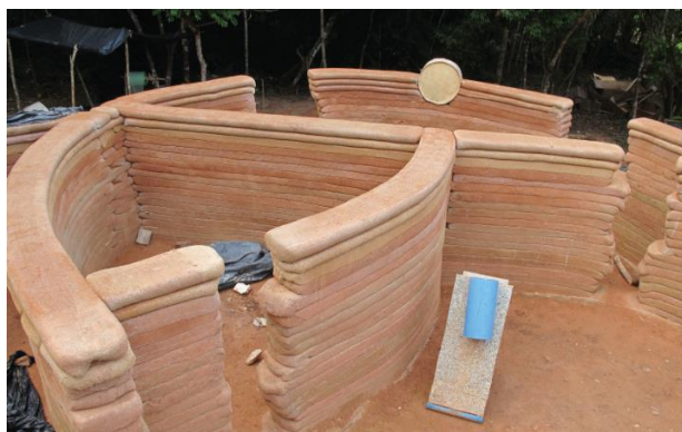
Figura 51: Detalhe de amarrações e o destaque das fiadas: Obra Casa Flor da Vida, BioHabitat, 2014.
