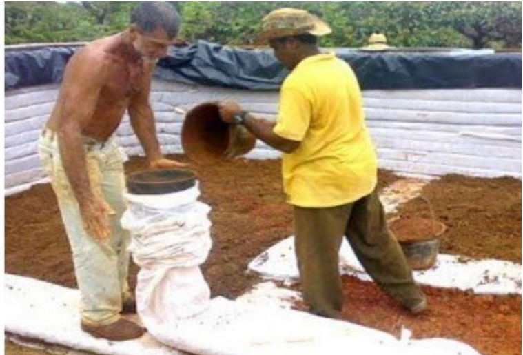
Figura 42: Enchimento da sacaria com terra, sem uso de cavalete.
