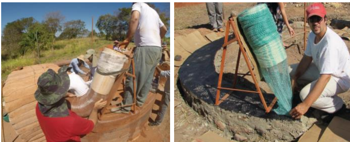
Figura 49: Modelo de cavalete utilizado em obras da empresa BioHabitare.
