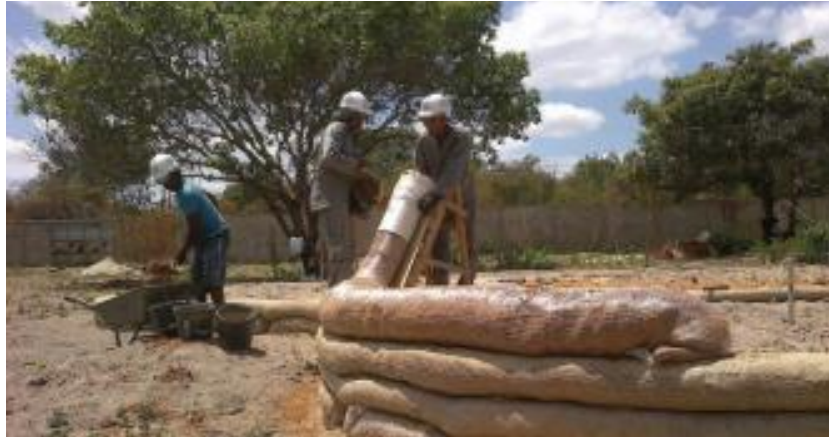
Figura 48: Exemplo de equipe de trabalho em 3 pessoas na construção com Hiperadobe.
