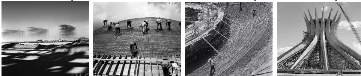
Figura 11: A construção de alguns edifícios de Brasília evidenciando o uso do aço e do cimento nas estruturas de concreto armado - Esplanada dos Ministérios, Senado Federal, Câmara dos Deputados e Catedral Metropolitana.
