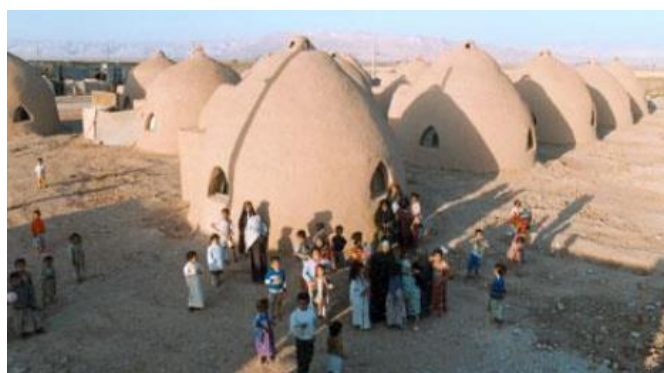
Figura 40: Superadobe usado em campos de refugiados das Nações Unidas.
