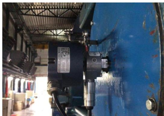
Figura 51 - Sensor de posição do eixo instalado no motor 18V46 na UTE Raesa.
