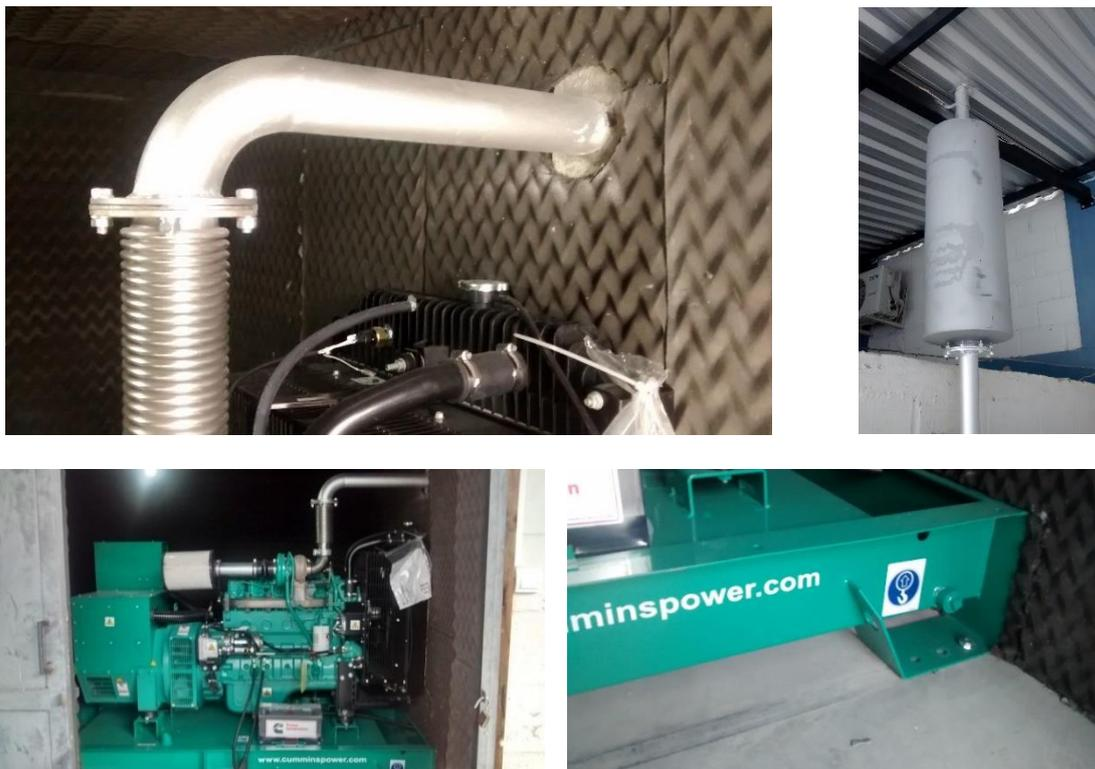
Figura 8 - Instalações dos atenuadores de ruído e fixação do gerador.
