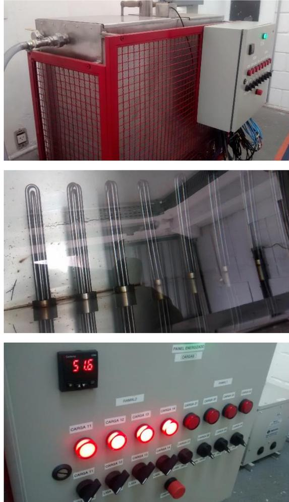
Figura 20 - Carga elétrica (banco de resistência) aplicada ao carregamento da unidade geradora.
