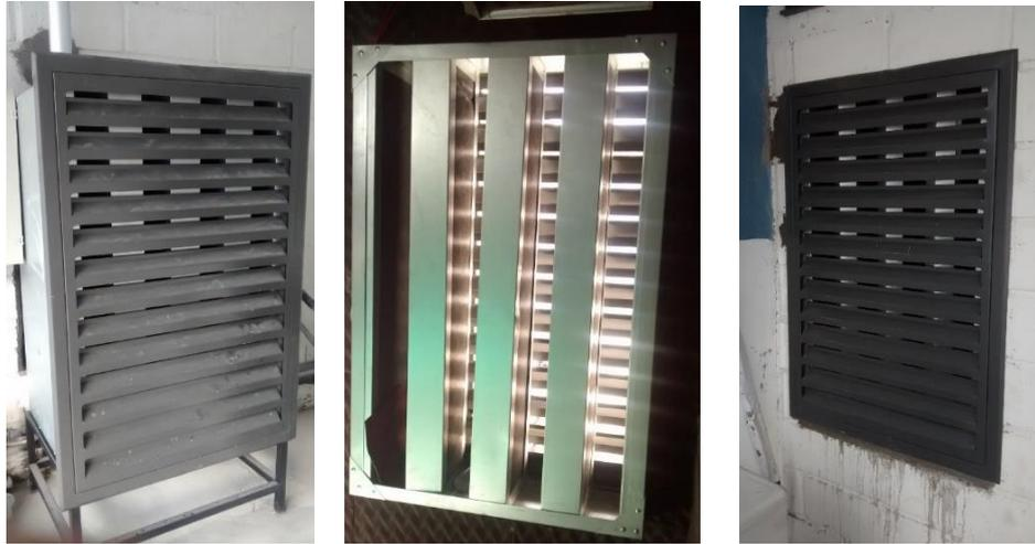
Figura 7 - Instalações dos atenuadores de ruído do gerador.
