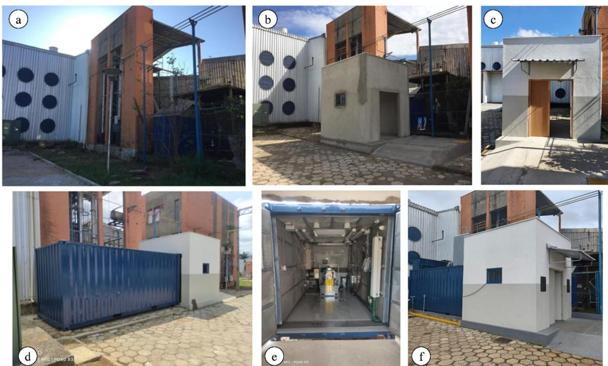
Figura 8: (a) Espaço disponibilizado na UNIFEI para a instalação do novo laboratório; (b) Início da construção de alvenaria da sala de controle; (c) Finalização da sala de controle; (d) Instalação do *test-container*; (e) Vista interna do *test-container*; (f) Finalização da construção do novo laboratório
