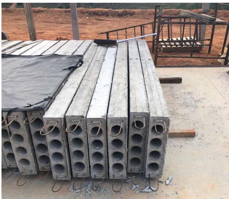
Figura 4. Placas Alveolares Pré-Moldadas. Fonte: Fabrica BeloForte
