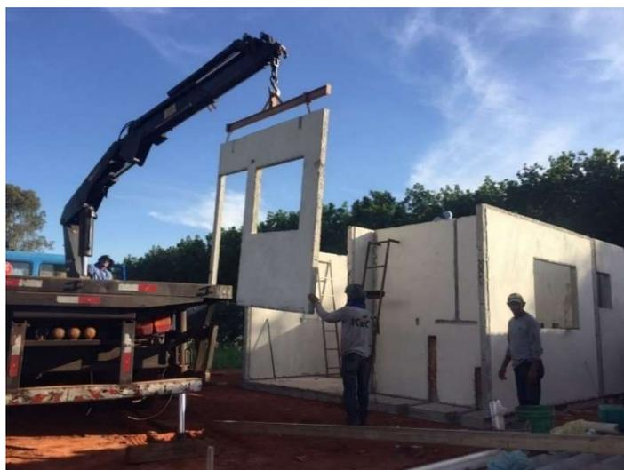
*Figura 11. Modelo de construção por placas pré-moldadas.*
