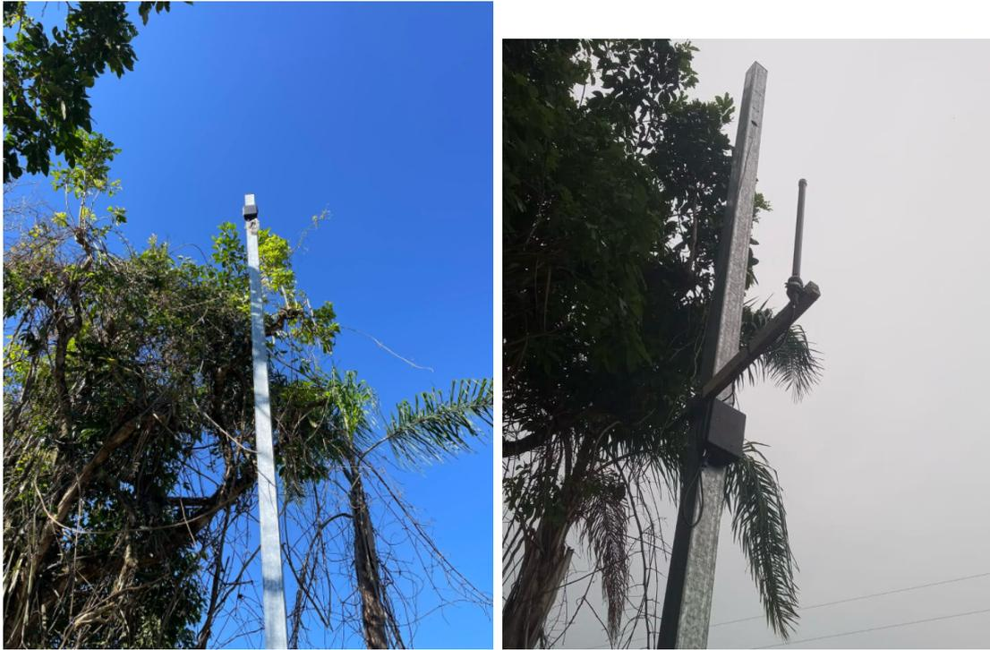
Figura 13: Instalação do ED 4 na Serra dos Toledos (Ponto 1) com antena de 2 dBi (esquerda) e 6.5 dBi (direita).
