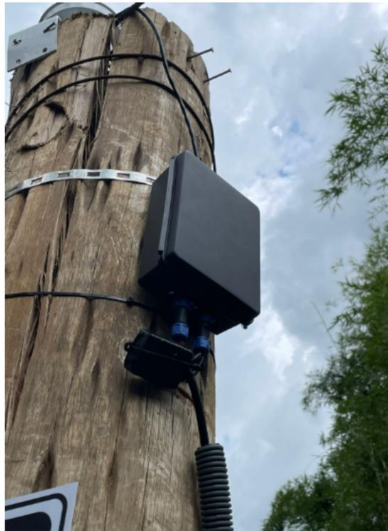
Figura 15: Instalação do ED 6 no Bairro dos Borges com antena de 2 dBi.
