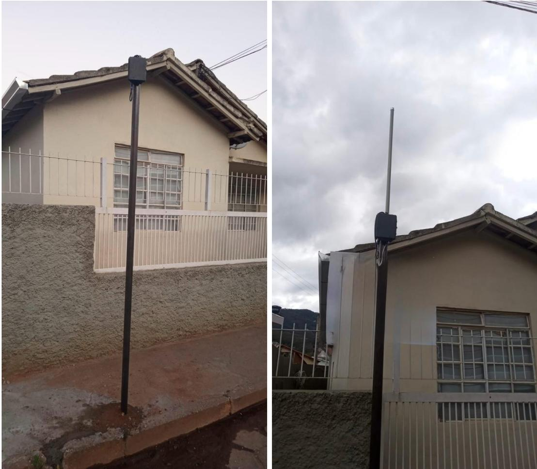
Figura 10: Instalação do ED 1 na Rua Tatuí com antena de 2 dBi (esquerda) e 6.5 dBi (direita).
