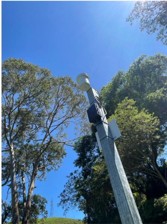
Figura 14: Instalação do ED 5 na Serra dos Toledos (Ponto 2) com antena de 2 dBi.
