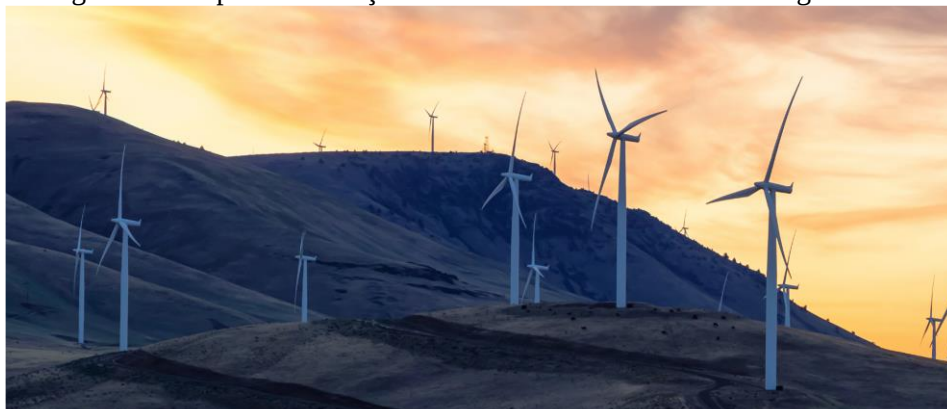
Figura 8: Campo de instalação de turbinas de conversão de energia eólica.
