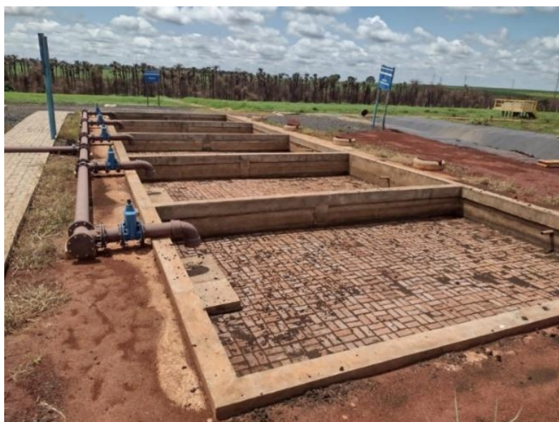
Figura 13 - Leitos de Secagem
