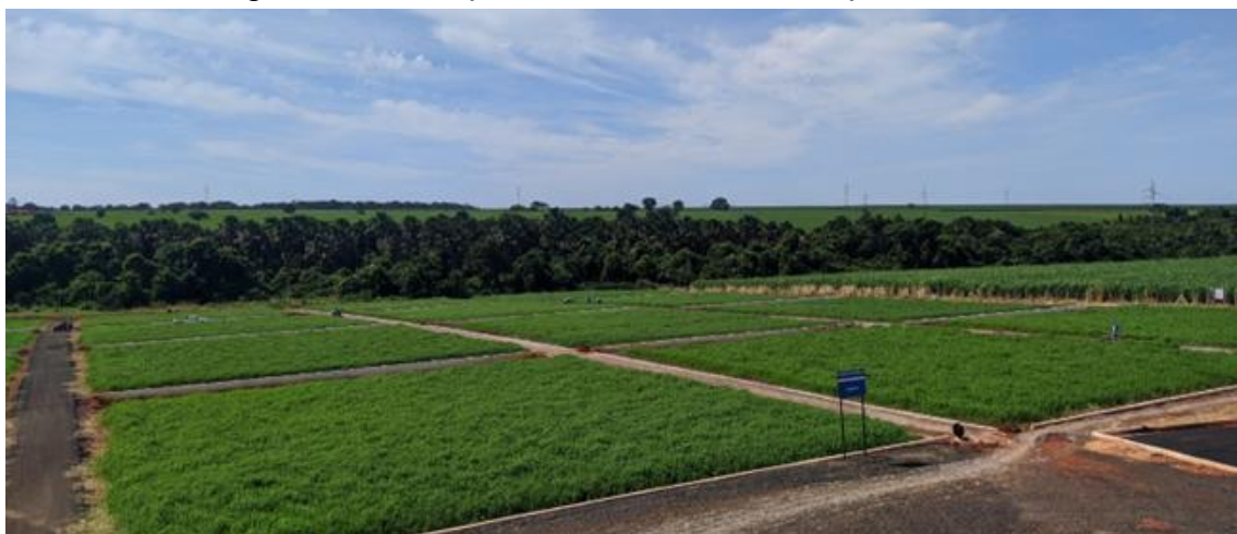
Figura 15 - Rampas de escoamento à superfície
