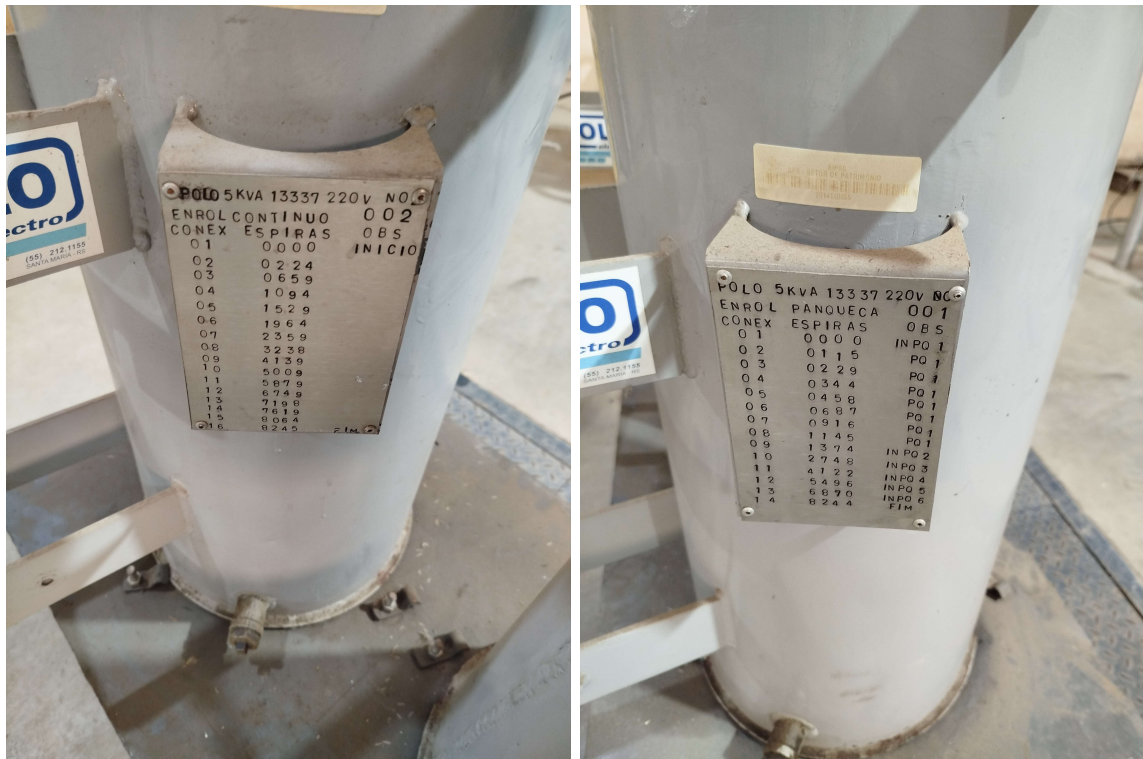
(a) Dados de placa - transformador 01
