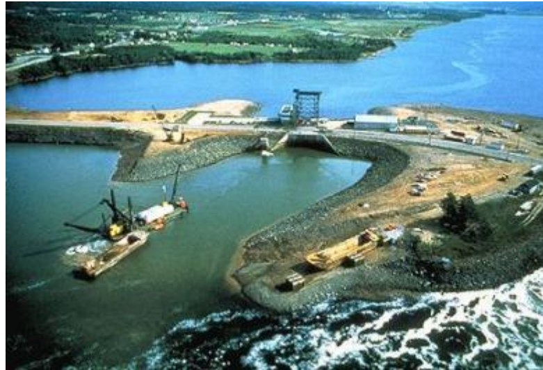
Figura 2. 6: Vista aérea da usina maremotriz de Annapolis. Fonte: ( http://www.thecanadianencyclopedia.com/articles/tidal-energy ; acessado em 13/11/2012).
