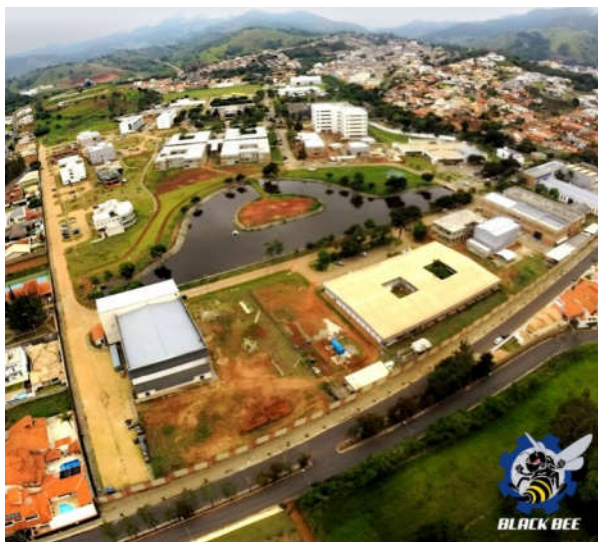
Figura 24 - Aplicação de Vant em fotografia aérea Fonte: autoria própria.
