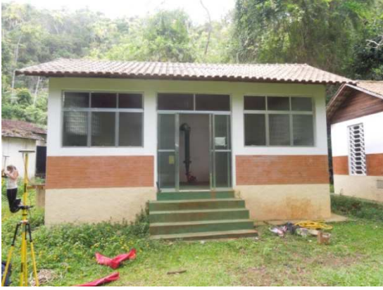
Casa de máquinas
