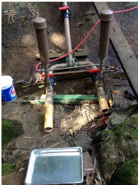
Figura 3.20- Tentativa de medir a vazão perdida no processo de funcionamento dos carneiros hidráulicos com a utilização de tubos de PVC
