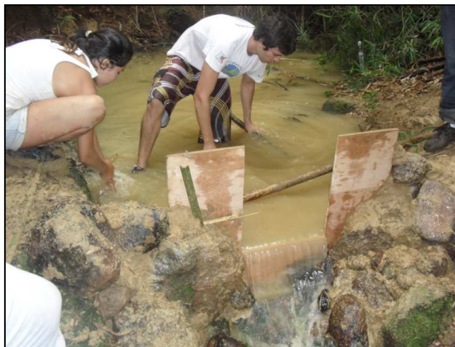
Figura 4.3- Participação da equipe do PEIA na instalação do vertedor
