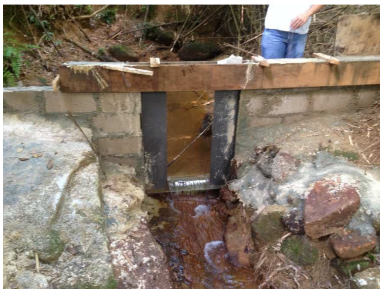
Figura 4.7- Novo vertedor instalado
