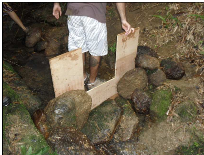
Figura 4.2- Instalação do vertedor
