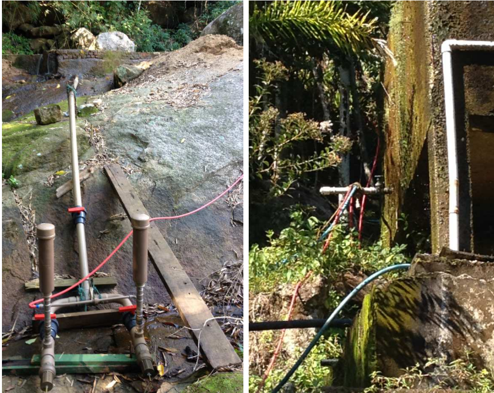
Figura 4.55- a) Instalação dos carneiros hidráulicos b) Chegada da tubulação de recalque no tanque de abastecimento
