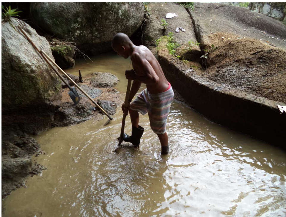
Figura 4.49- Limpeza da pequena barragem assoreada
