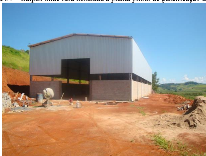
Figura 34 – Galpão onde será instalada a planta piloto de gaseificação de RSU.
