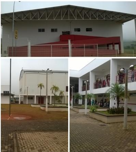
Figura 08: Prédio de Eng. Civil - Campus Pouso Alegre. Fonte: arquivos pessoais, 2016.
