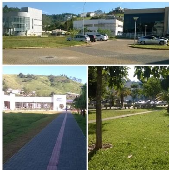
Figura 15: Prédios de eng. e centro de convivência - Campus Itajubá Fonte: arquivos pessoais, 2016.
