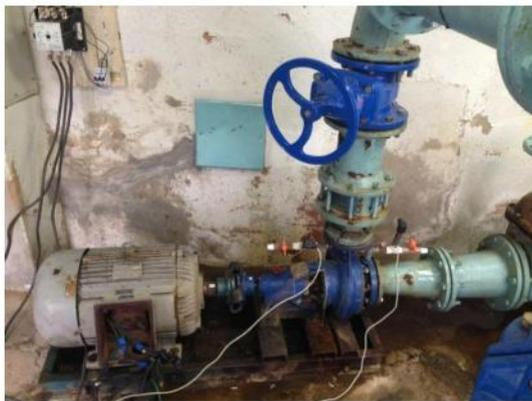
Figura 16 - Transdutores de pressão na entrada e saída da bomba
