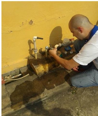
Figura 18 - Instalação de um dos *DATA*Loggers.
