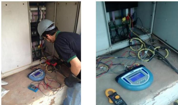
Figura 13 - Analisador de energia utilizando as medições.
