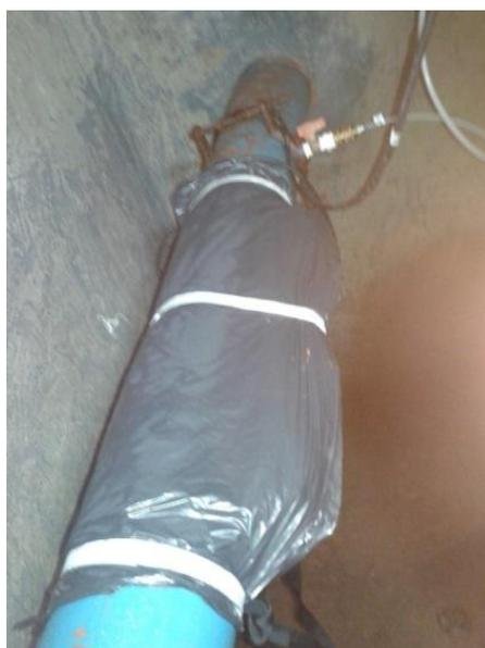
Figura 23 - Sensores do medidor de vazão instalado no poço de visita protegido contra umidade
