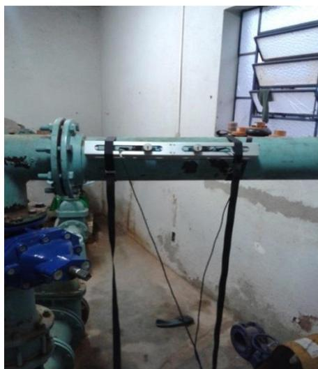
Figura 21 - Sensores do medidor de vazão já instalados
