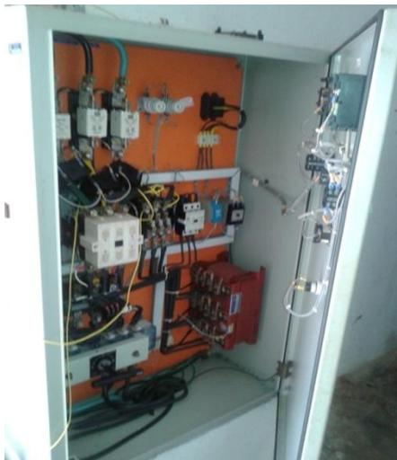
Figura 12 - Quadro de comando e proteção do motor
