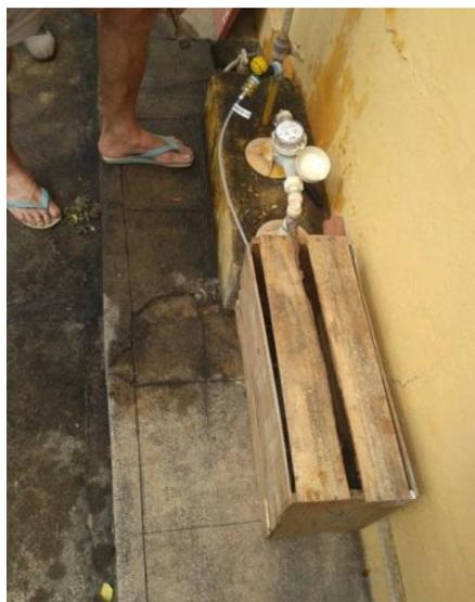
Figura 19–*DATA*Logger instalado e protegido.
