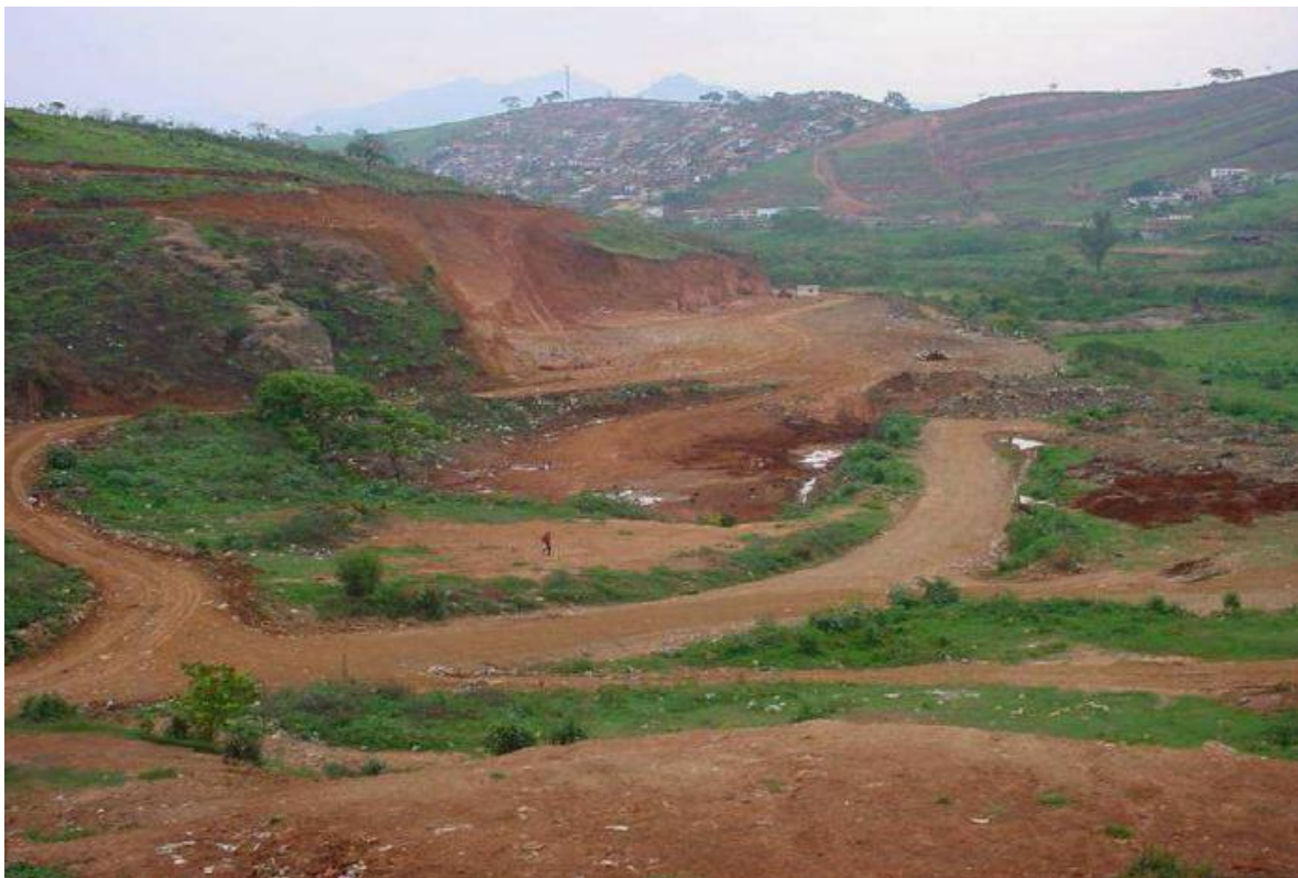
Figura 5.2: Visão geral do Aterro Sanitário de Itajubá ( PGIRSU, 2007).
