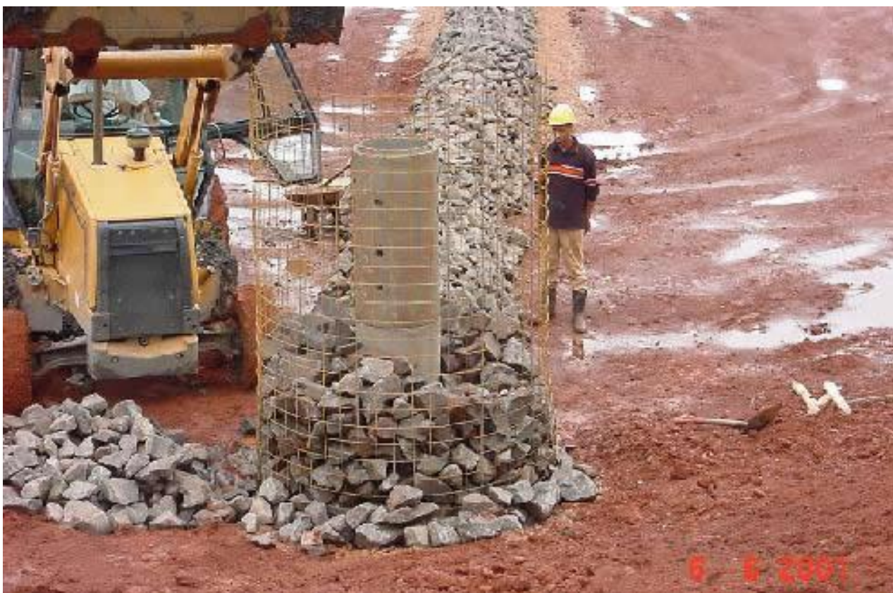
Figura 4.2 Dreno de biogás em um aterro sanitário (Sil Soluções Ambientais, 2008).
