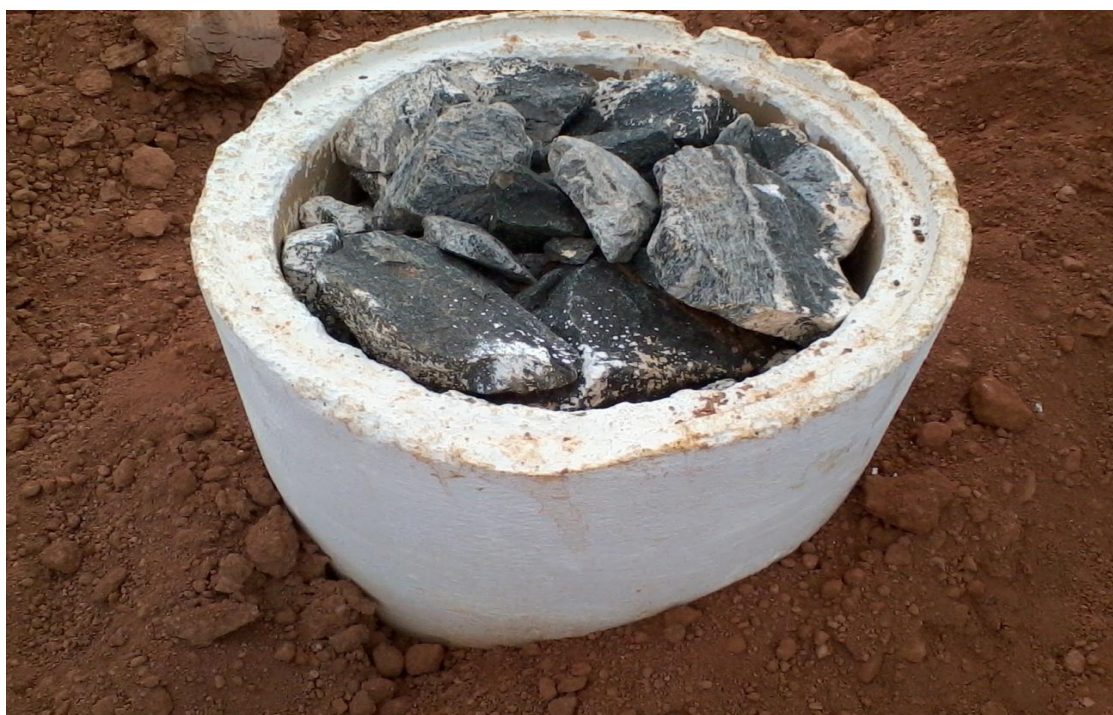
Figura 5.6: Dreno de biogás (PAIVA, 2012).
