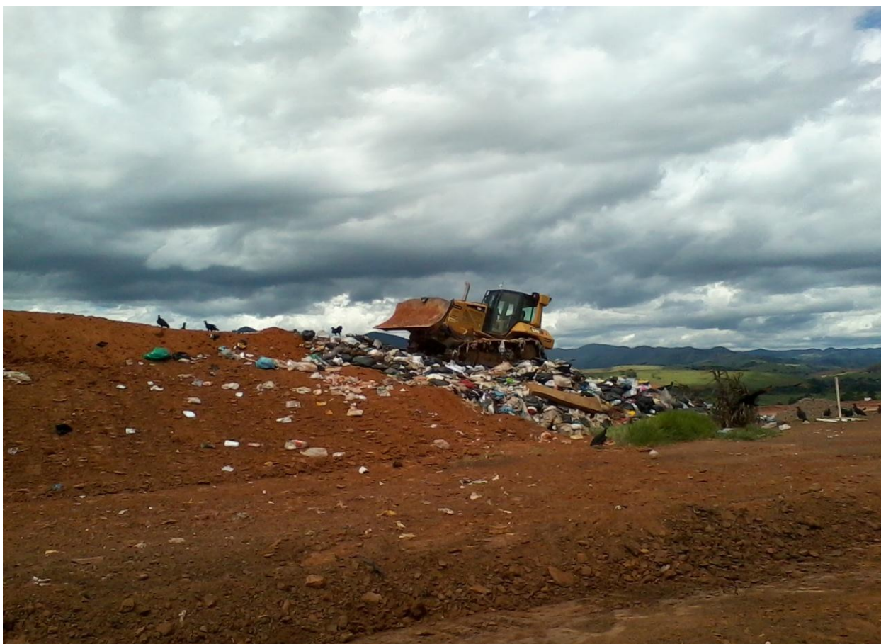
Figura 5.3: Talude para deposição de resíduos (PAIVA, 2012).
