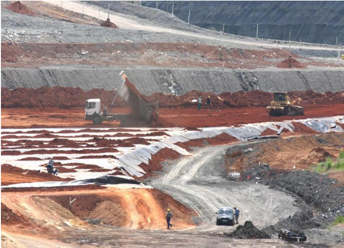
Figura 3.1 Exemplo de Aterro Sanitário ( Sil Soluções Ambientais, 2008).
