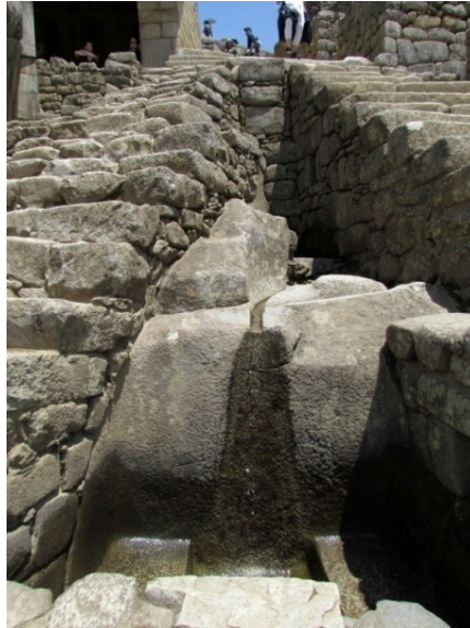
Figura 2 – Canal de drenagem na cidade peruana de Machu Picchu
