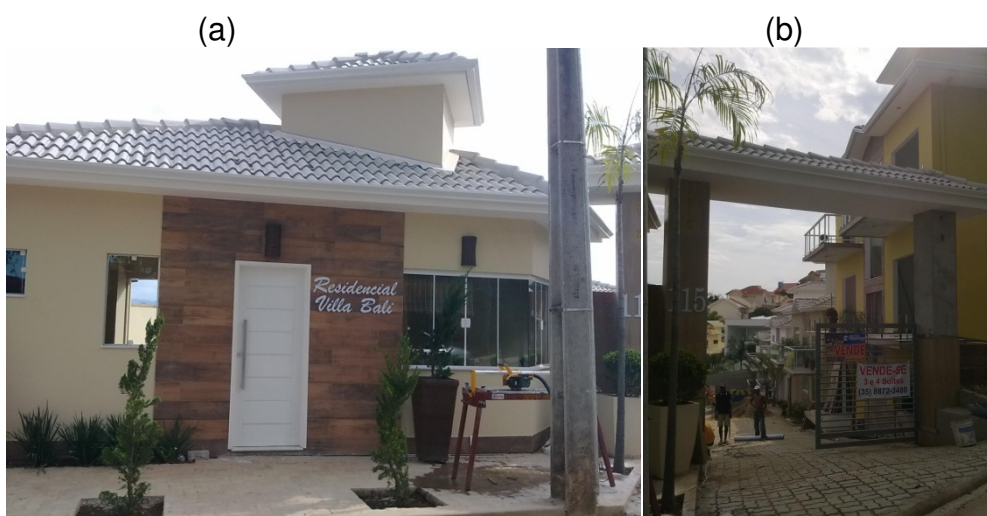
Figura 70 - Empreendimento residencial multifamiliar em fase de finalização no bairro Vale dos Pinheiros
