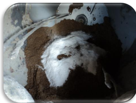
Figura 3.5: Componentes dentro da betoneira
