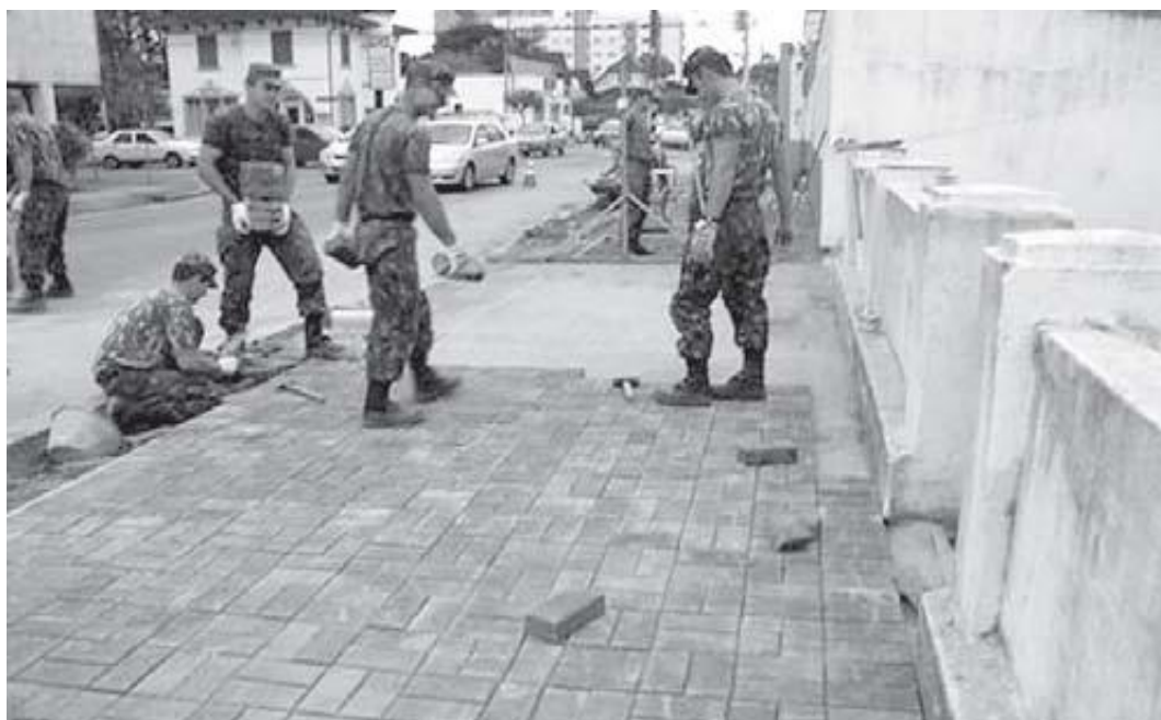
Figura 2.11 – Execução de pavimentação com as peças de concreto com ADF no entorno do 62º Batalhão de Infantaria de Joinville.
