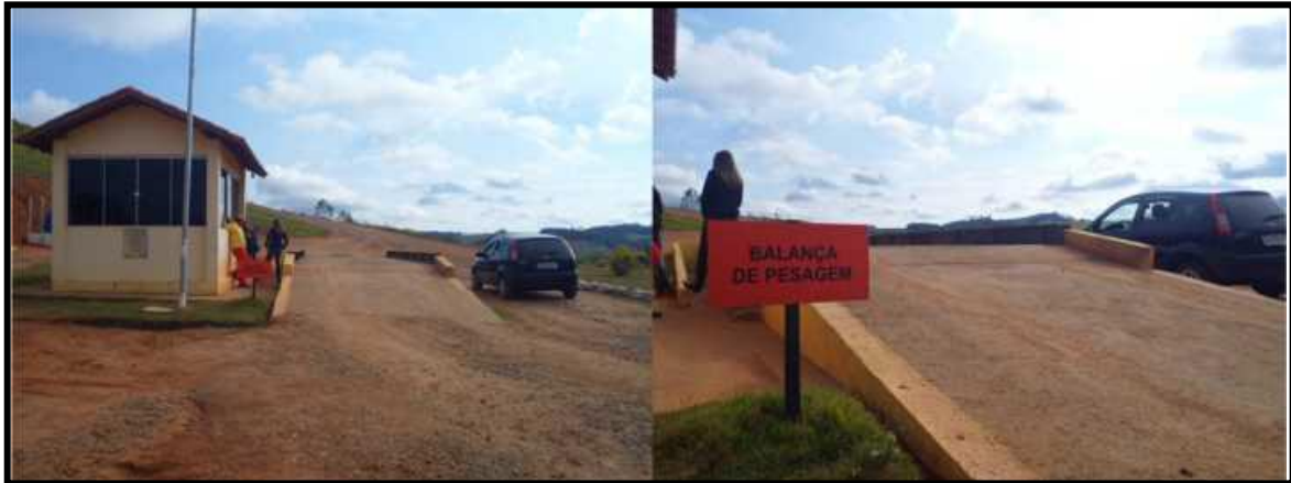
Figura 13 - Guarita de entrada e balança do aterro sanitário
