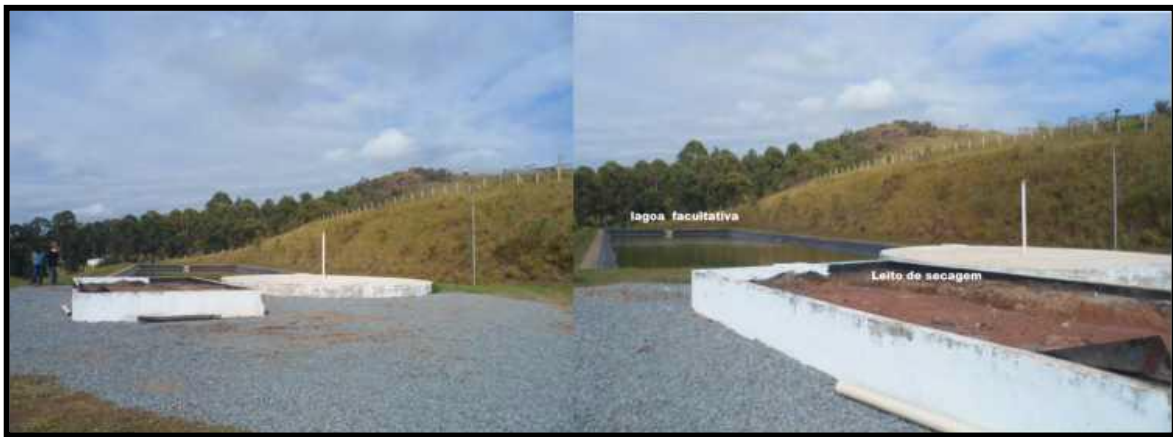
Figura 14 - Estação de Tratamento de Efluentes
