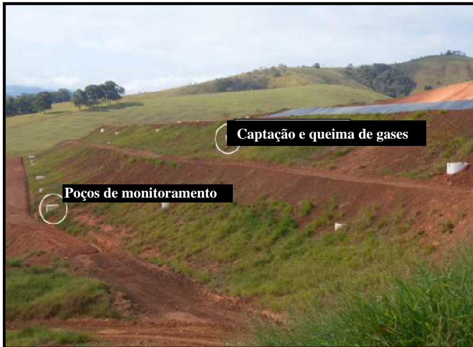
Figura 12 - Taludes, poços de monitoramento e queimador de gás do aterro sanitário
