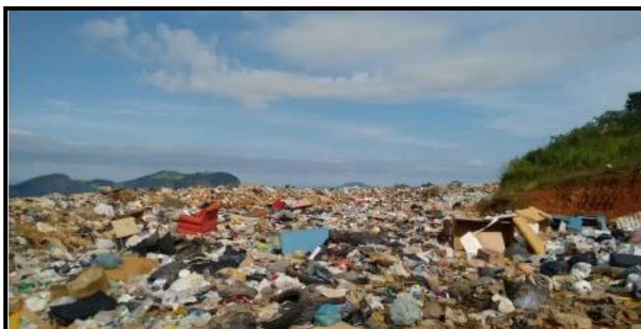
Figura 27: Panorama fotográfico do aterro controlado da Prefeitura Municipal B
