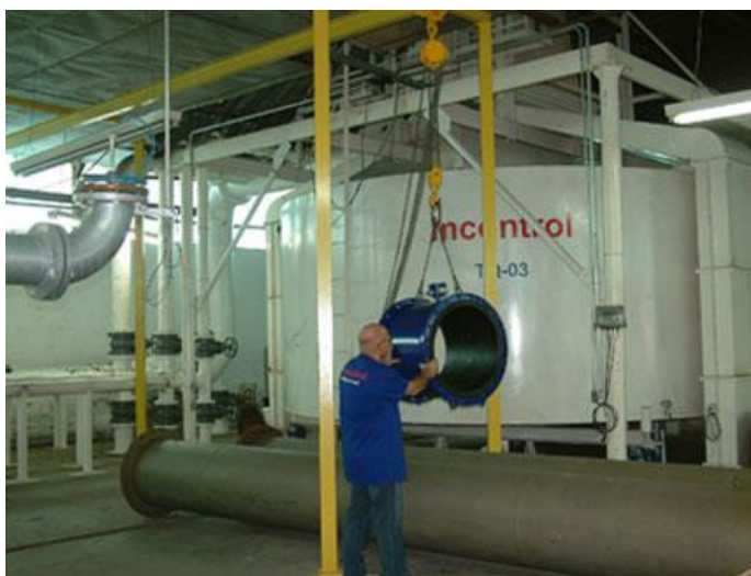
Figura 6.1. Instalação da Incontrol
