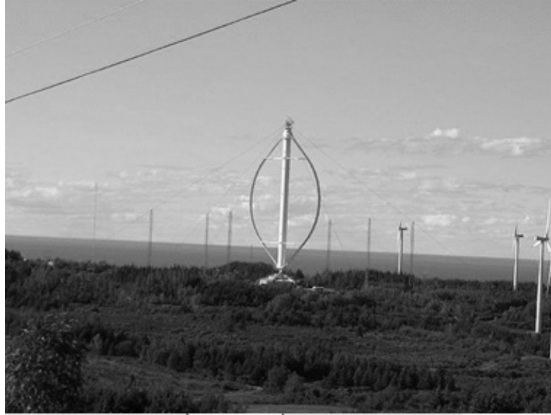
Figura 1.6: Turbina Darrieus com duas pás Fonte: Czecoski (2015)
