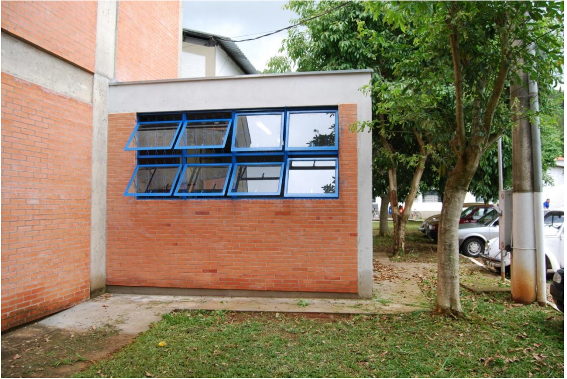
Figura 156 – Vista lateral do laboratório de ondas.
