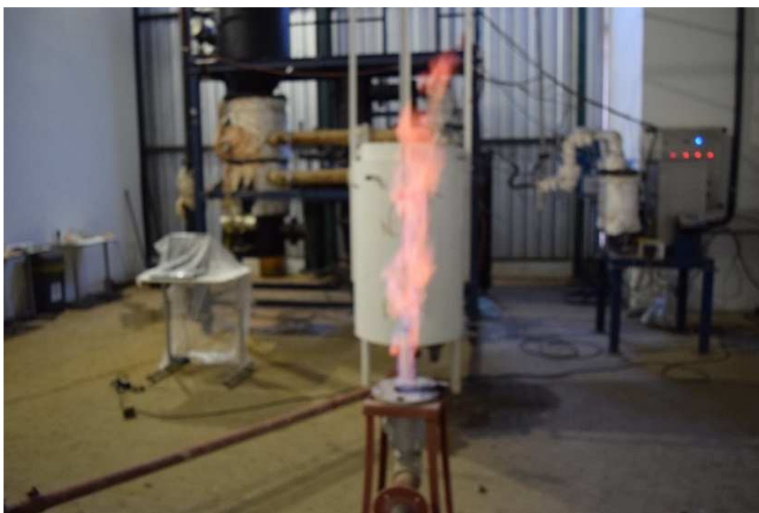
Figura 3-18 Montagem do processo de gaseificação - Tanque de armazenagem de gás e gaseificador de leito fixo
