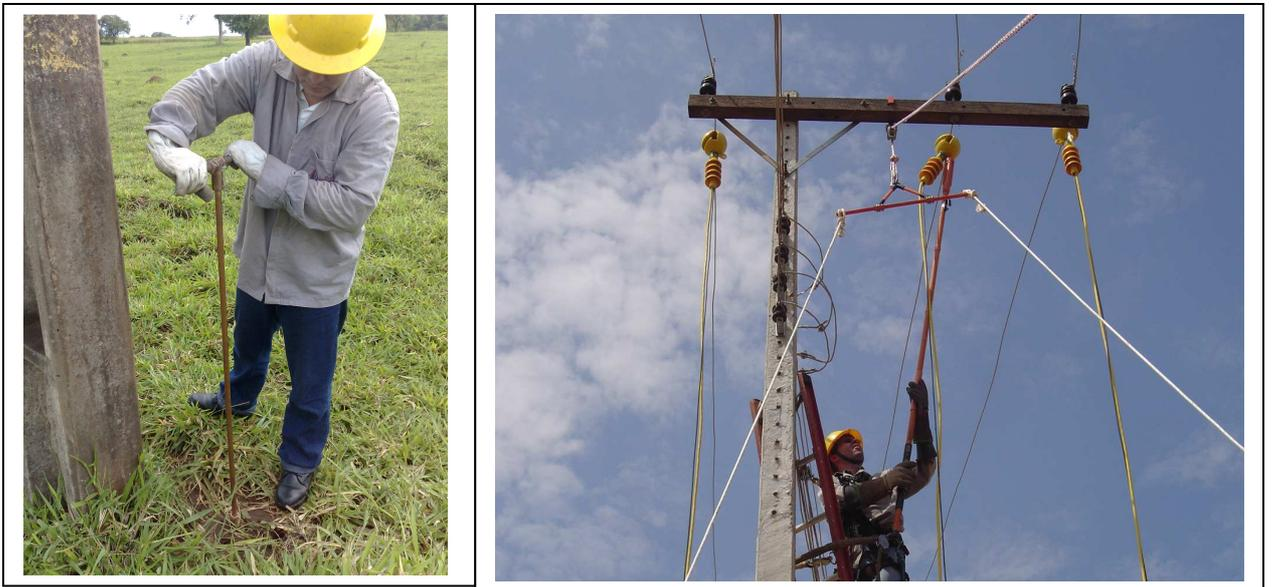
Figura 3.7 - Preparação do aterramento e instalação das garras.
