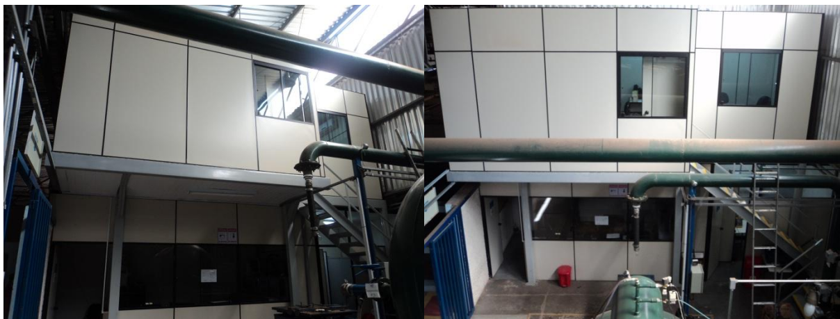
Figura 5.4: 1º e 2º pisos reformados.
