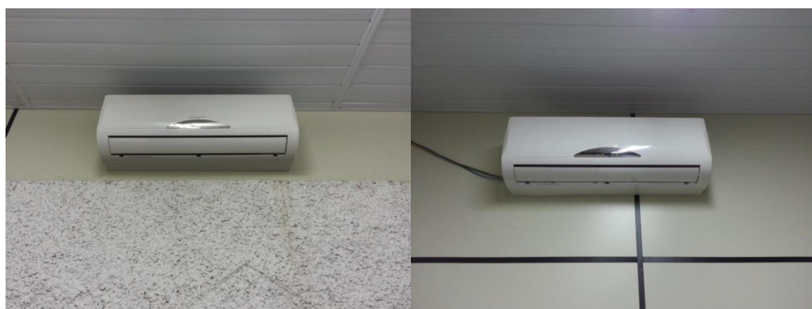
Figura 5.6: Colocação do ar condicionado nas salas do 1º e 2º pisos.
