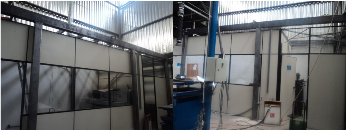
Figura 5.2: Reforma da sala de controle do LEB-UNIFEI.
