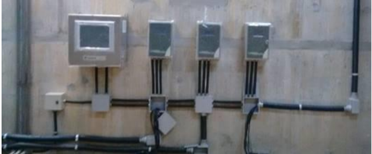
Figura 39 – Medidores de vazão instalados, em fase de acabamento.
