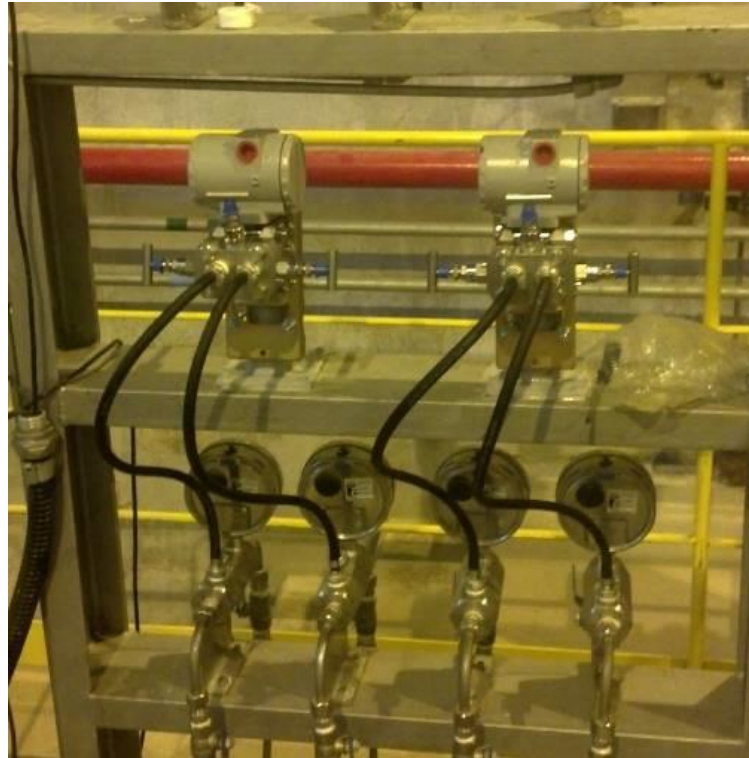
Figura 3 - Medidor de pressão diferencial analógico - método Winter-Kennedy e Pitot Fonte: Acervo próprio
