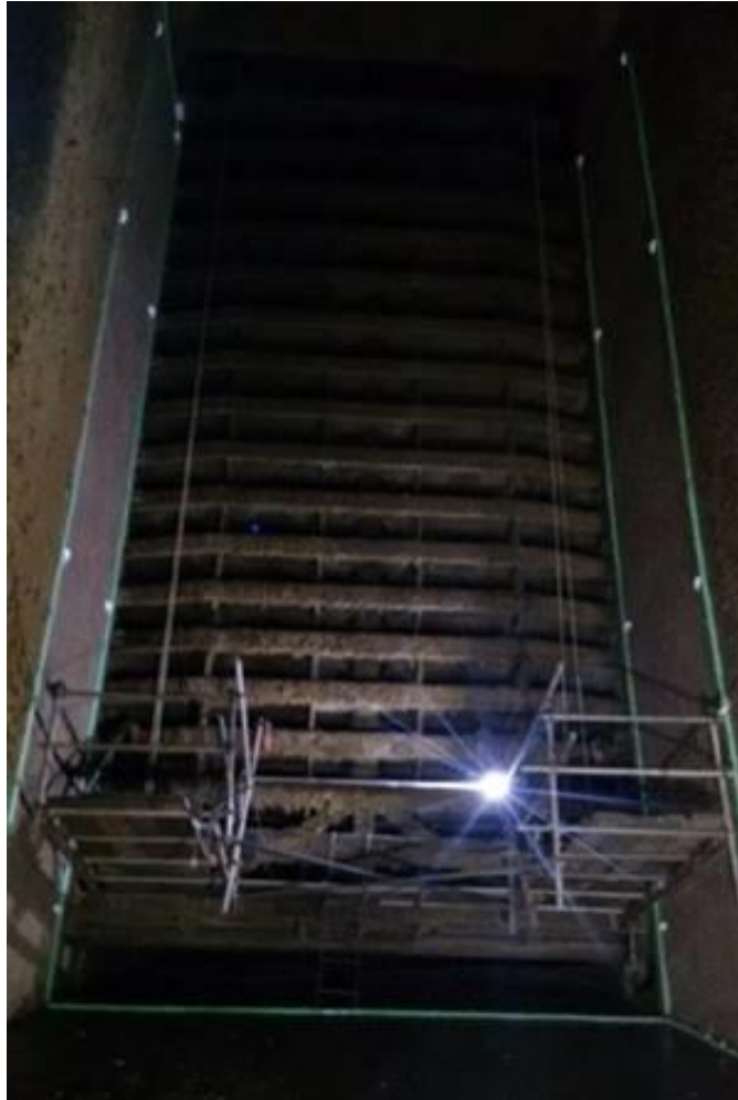
Figura 42 - Transdutores já instalados na Baia C (16 transdutores).
