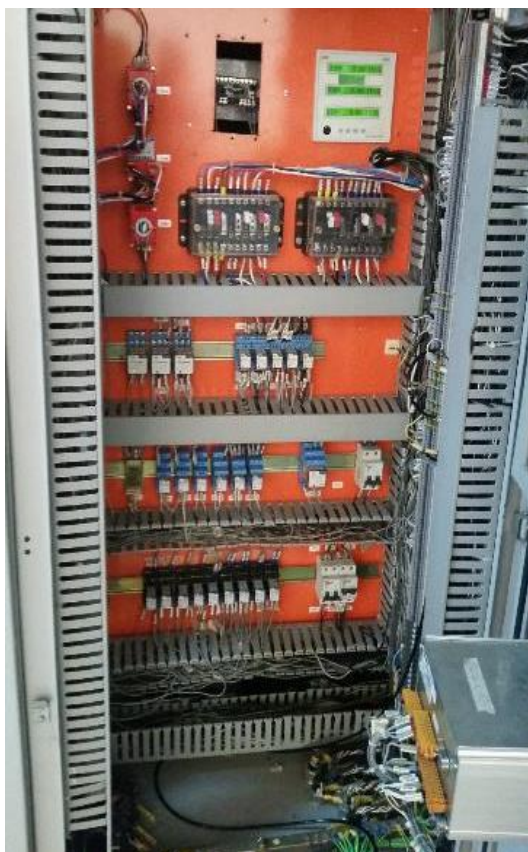
Figura 60 - Conexões no painel do Regulador de Velocidade
