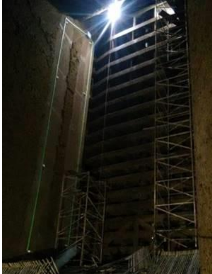
Figura 41 - Transdutores já instalados na Baía B (16 transdutores). Fonte: Acervo próprio
