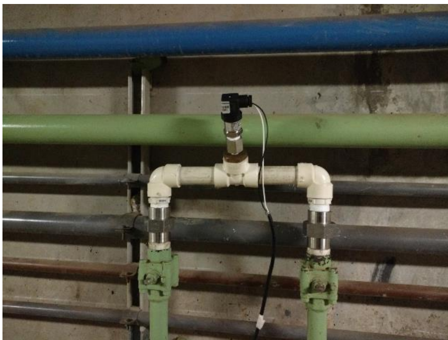
Figura 62: Transmissor de Pressão da Saída da Caixa Semi-Espiral
