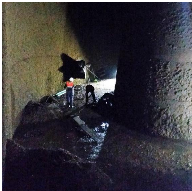
Figura 50 - Incrustações do Mexilhão Dourado no interior da Caixa Semi-Espiral
