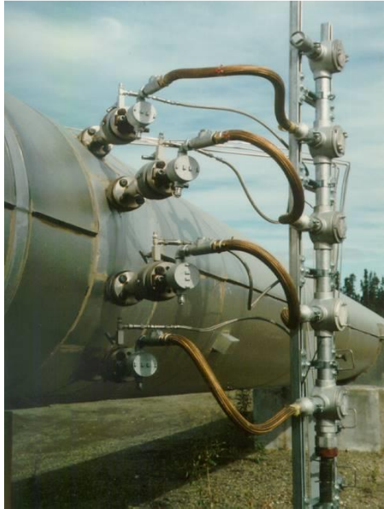
Figura 11 - Medidor ultrassônico por Tempo de Trânsito - múltiplos caminhos
