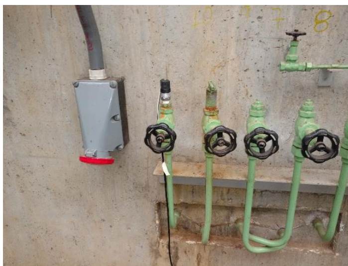
Figura 61: Transmissor de Pressão da Entrada da Caixa Semi-Espiral
