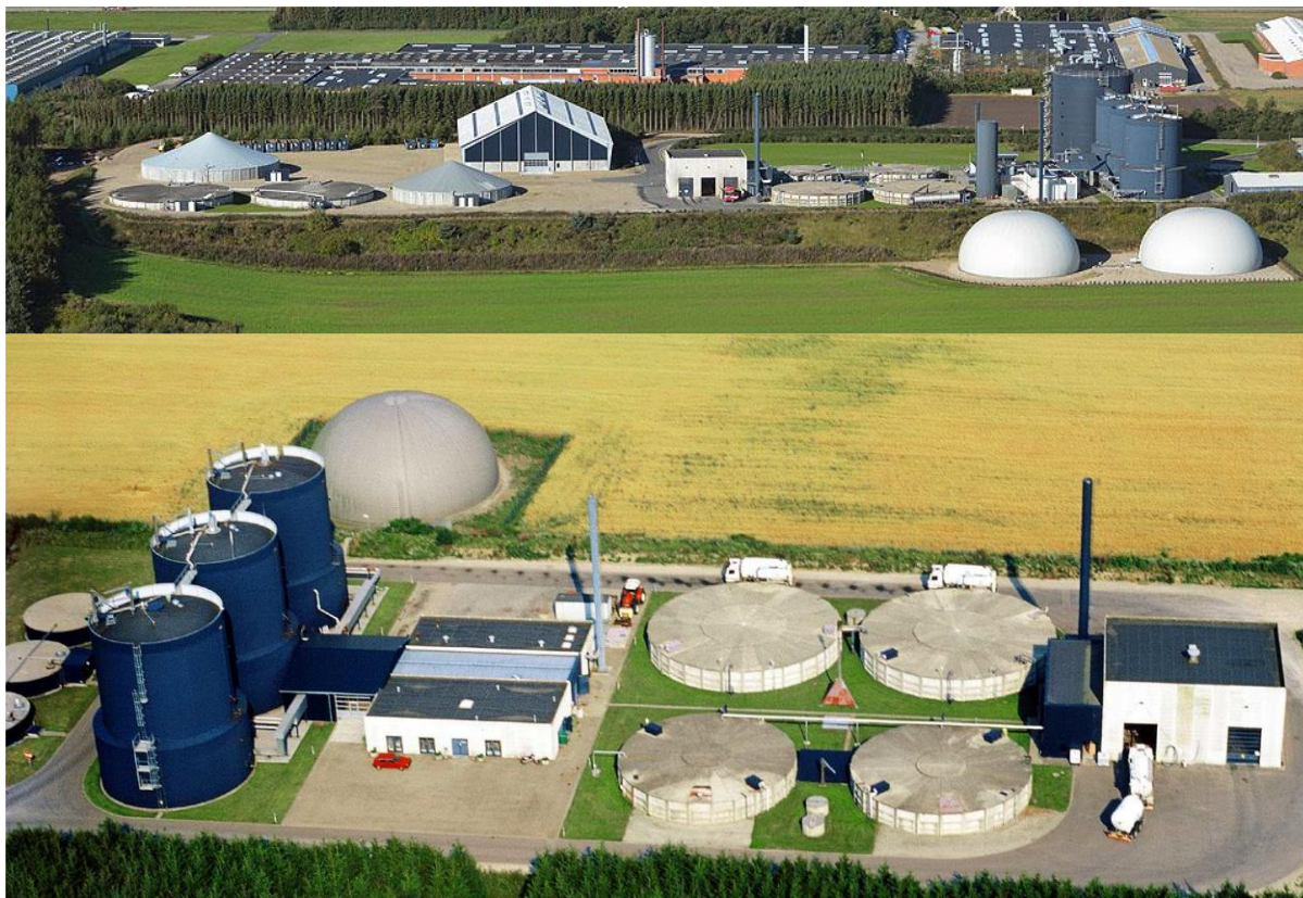
Figura 3.12 – Usina de biogás Lemvig, Dinamarca
