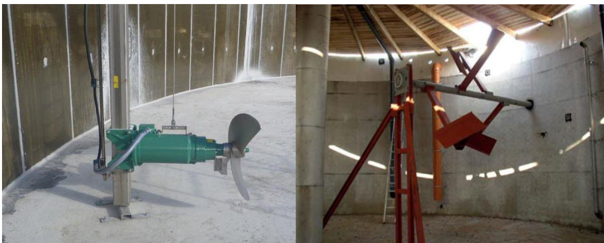
Figura 2.7 – Agitadores para biodigestores: (a) agitador axial submergível com altura ajustável (esquerda), (b) agitador de pá
