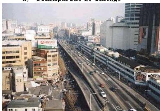
c) Viaduto sobre o Rio Cheonggyecheon
