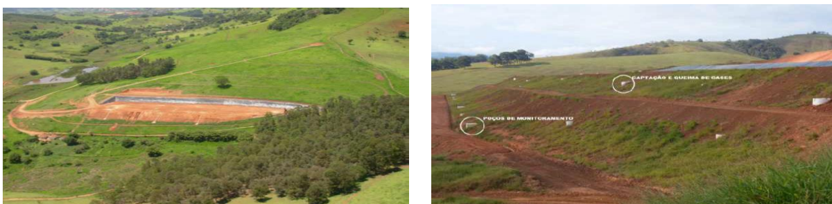
Figura 3.1 Aterro Sanitário de Itajubá. Fonte. Gonçalves (2007)
