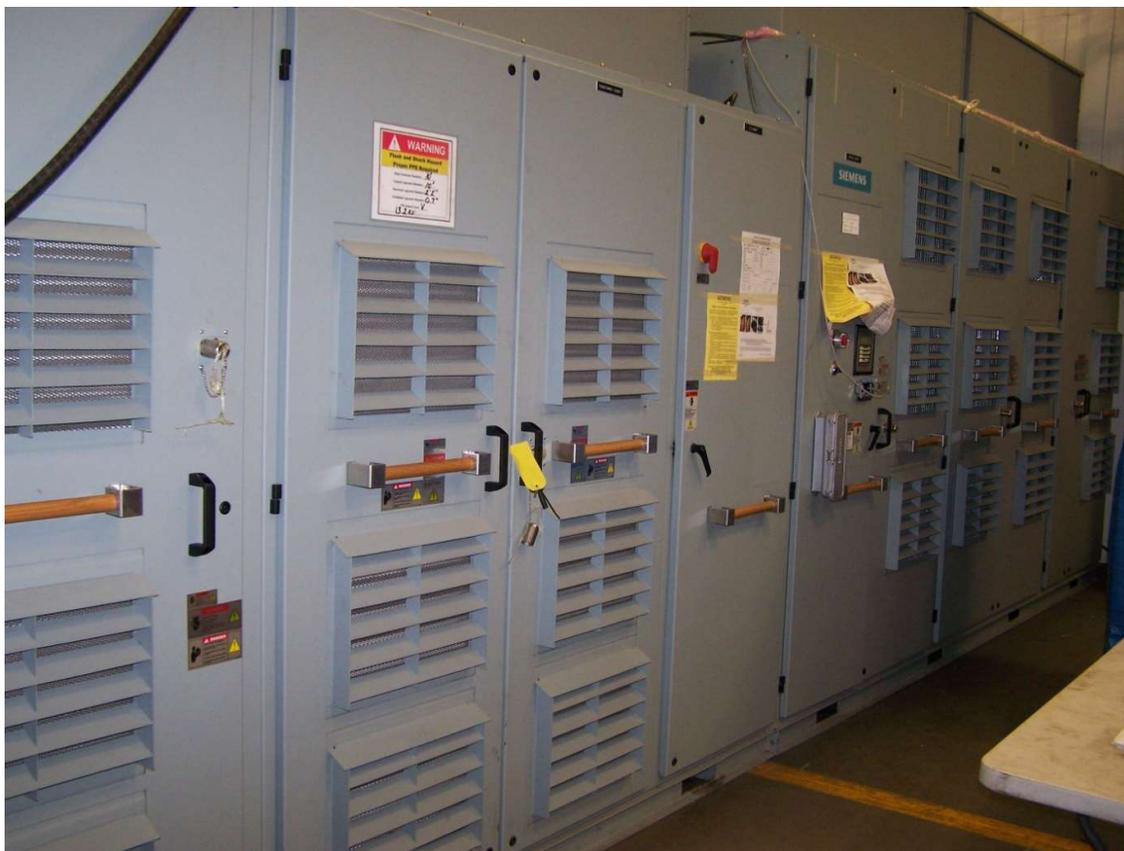
**Figura 3.8-** Conversor de frequência CHBI de MT - 2000 HP – tensão de saída 0 - 6,6 kV para testes de BCSS
