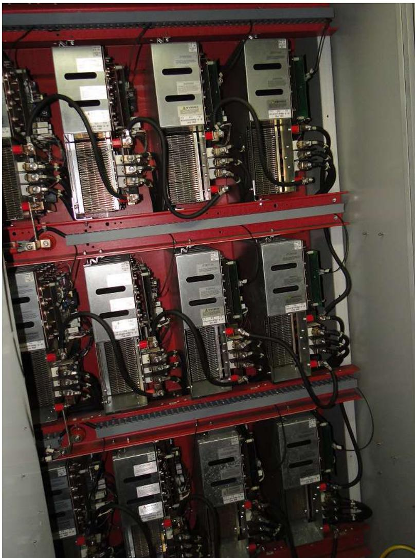
**Figura 4.3-** Células de potência de um conversor de frequência para BCSS.
