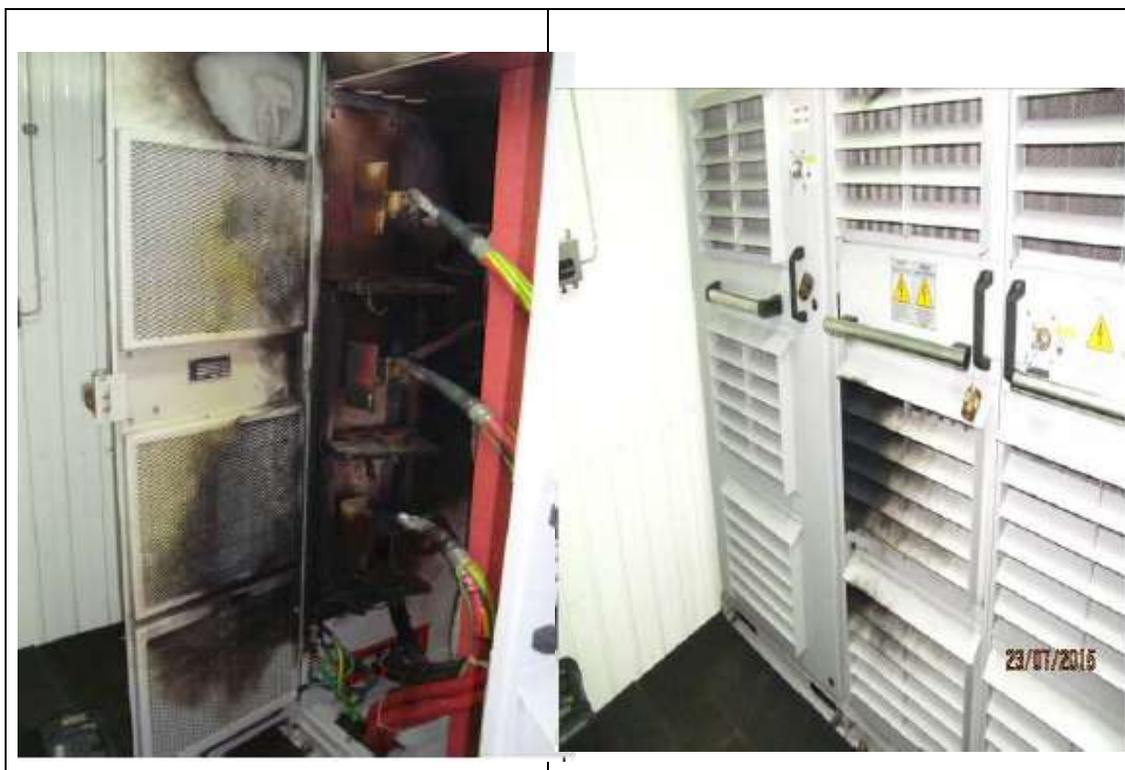
**Figura 5.6-**Falha de curto-circuito na entrada do VFD;
