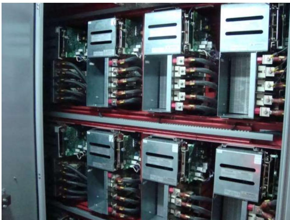
**Figura 5.5**-Célula de potência A2 do conversor de frequência apresentou falha na fibra ótica;
