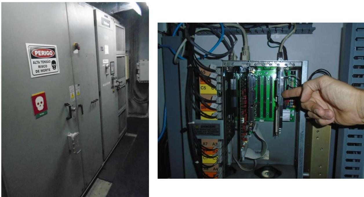
**Figura 5.3-** VFD CHBI acionamento de BCSS em plataforma falha placa microprocessora com parada de produção;
