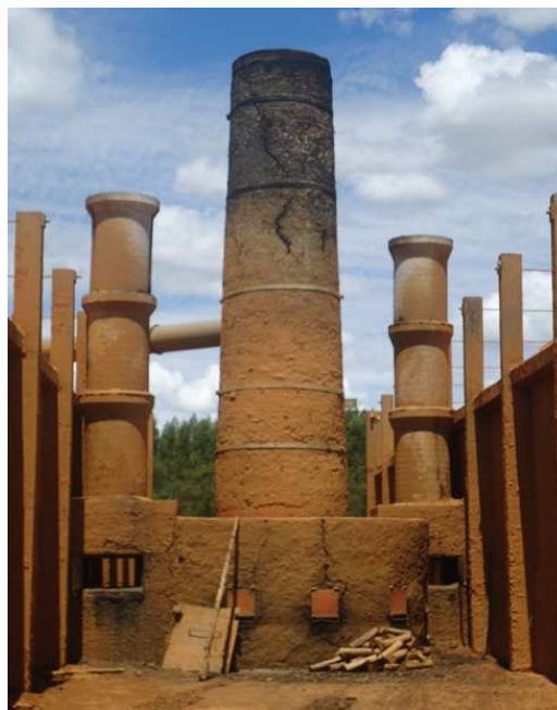
Figura 3.5. Queimador Circular da Arcelor Mittal ligado a dois fornos retangulares (Arcelor Mittal, 2012).
