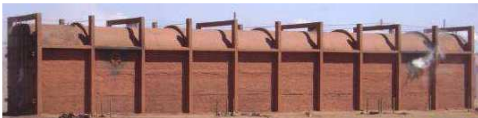
Figura 2.15. Forno retangular utilizado para produção de carvão vegetal da Plantar Energética em Itacambira (MG).
