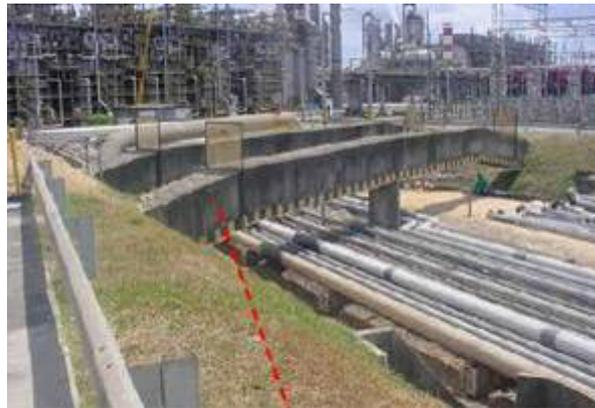
Figura 4.3.5 – Pontilhão para Cabos Elétricos. Fonte: Braskem
