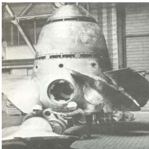
Fig. 3.18 Montagem de turbina Kaplan da Voith para a Usina Bernardo Mascarenhas (Três Marias), no rio São Francisco.
