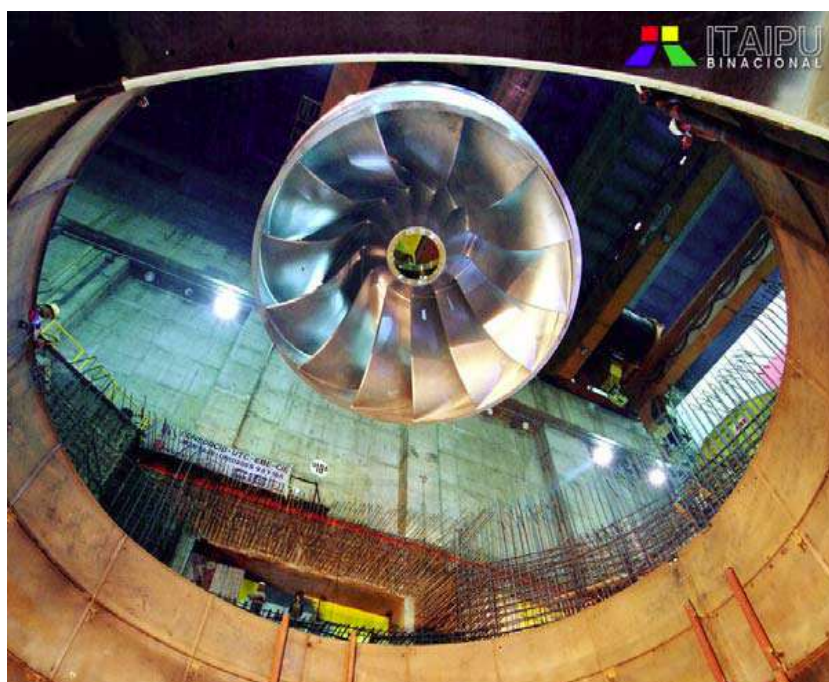
Fig. 3.15 Um rotor Francis da UHE Itaipu Binacional.
