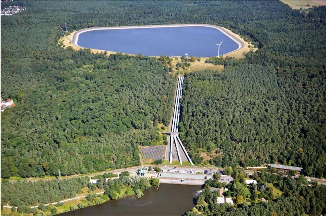
Figura 13. Usina reversível Geesthacht com complementação eólica na Alemanha
