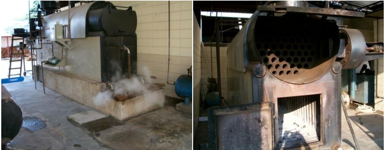
Figuras 4.79 e 4.80 - Caldeira utilizada nos experimentos de queima de biomassa picada
