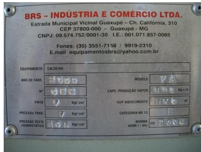
Figura 4.81 - Detalhes da placa de identificação da caldeira utilizada nos experimentos de queima de biomassa picada
