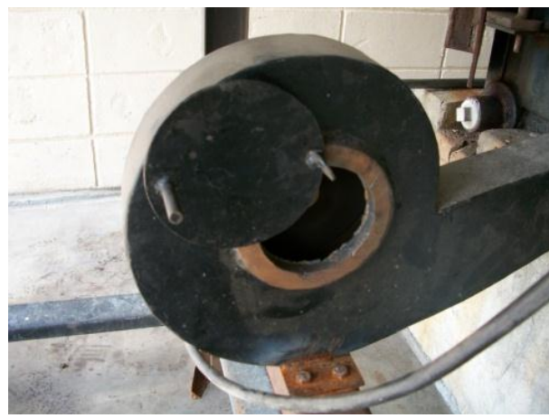
Figuras 4.84 e 4.85 - Detalhes do sistema de alimentação de biomassa para a caldeira
