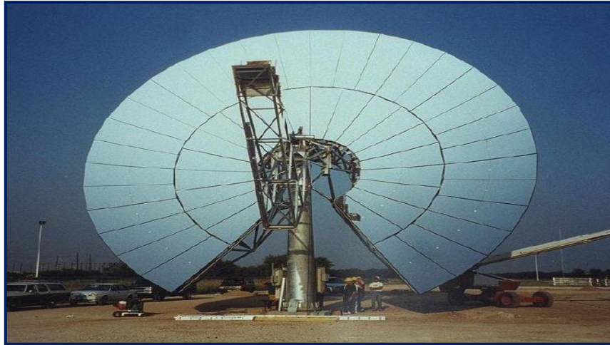
Figura 2.17 Sistema CPG de 25 kWe (Dracke e De Laquil III, 1996)
