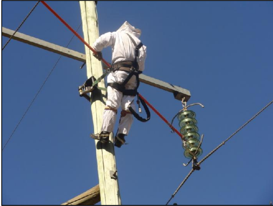
Figura 5.3 - Aplicação do dispositivo de simulação de descargas parciais em uma estrutura localizada na zona rural.
