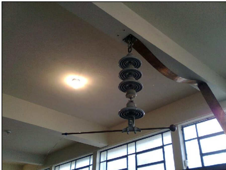
Figura 2.7 - Exemplo de cadeia de isoladores contendo um isolador quebrado sob ensaio em laboratório.
