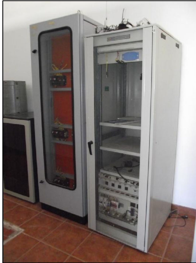
Figura 4.2 - Painel de telemedição (à direita) disponível para instalação do sistema de aquisição de sinais (SE São Gabriel).
