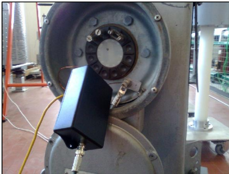
Figura 4.34 - Protótipo da caixa de aquisição instalada no aterramento de um dos TCs do LAT-EFEI.
