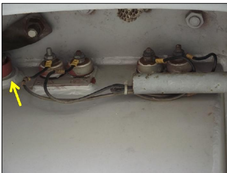
Figura 4.5 - Terminal de aterramento acessível em um dos TCs da SE Rosário.
