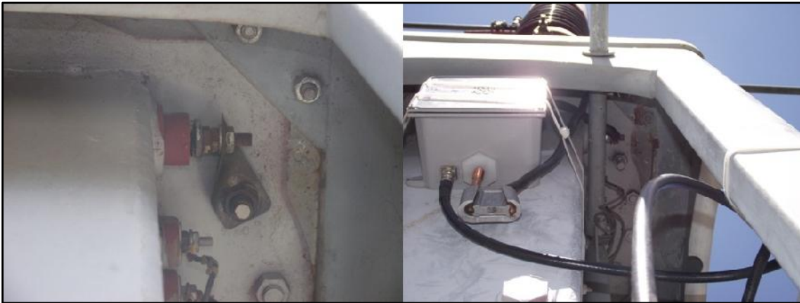
Figura 4.39 - Caixa de aquisição instalada em TC da SE Rosário (a direita). A imagem à esquerda mostra a conexão, em chapa metálica, que teve que ser seccionada para a instalação da caixa.
