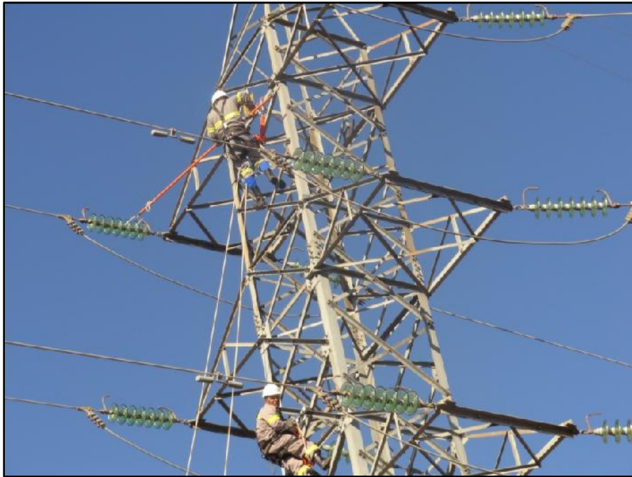
Figura 5.1 - Aplicação do dispositivo de simulação de descargas parciais na Estrutura 001 (área urbana).
