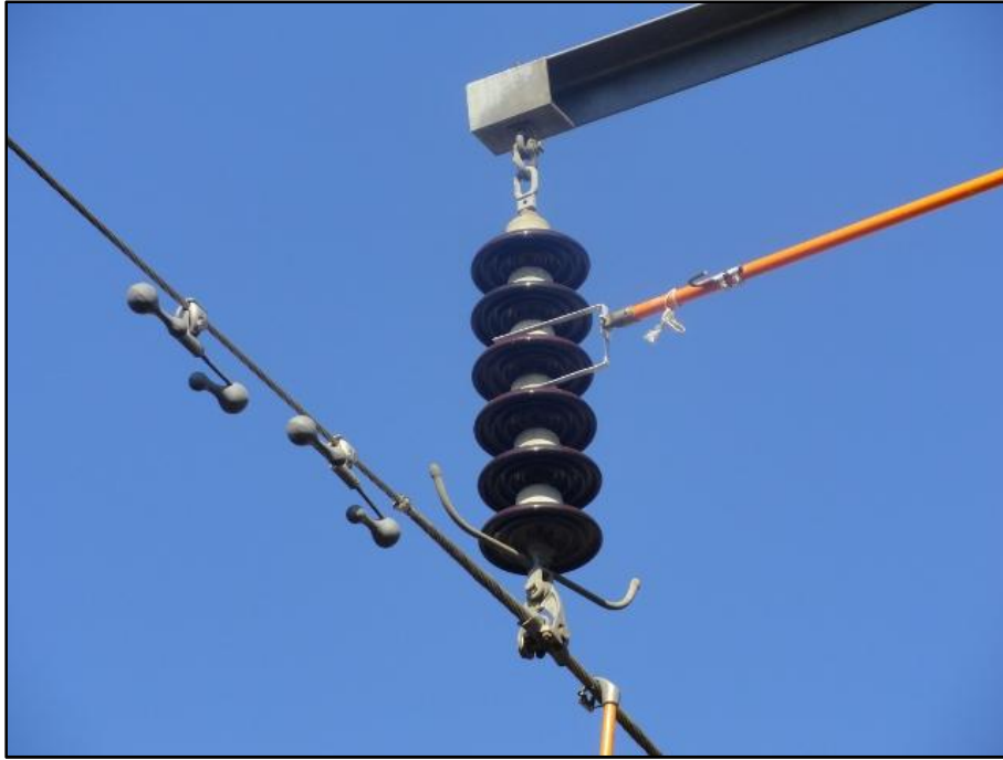
Figura 4.41 - Aplicação do garfo metálico em cadeia de porcelana da fase A da torre n° 228, próximo à SE São Gabriel.
