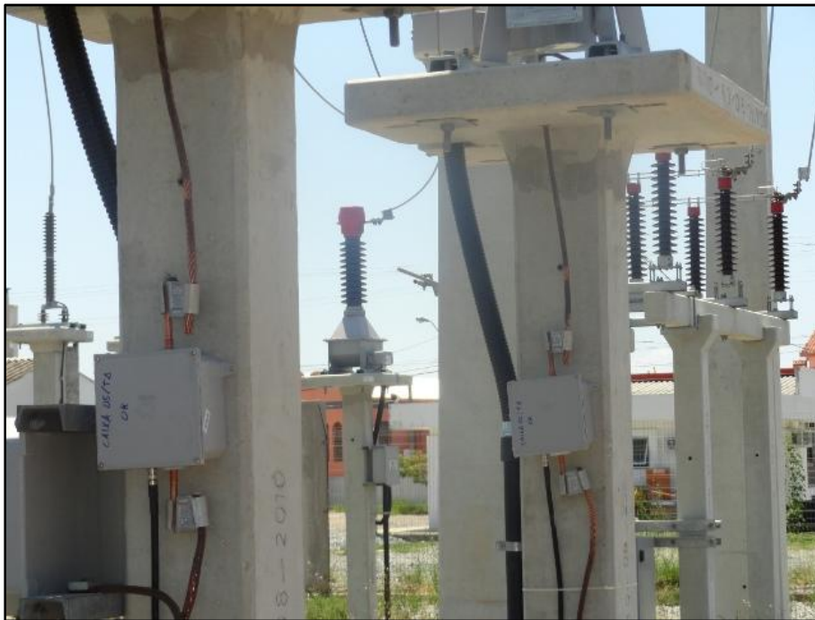
Figura 4.40 - Caixas de aquisição instaladas nos TCs da SE São Gabriel.
