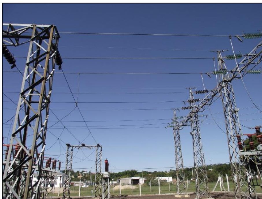
Figura 4.7 - Local pré-selecionado para instalação das bobinas de bloqueio na SE Rosário.
