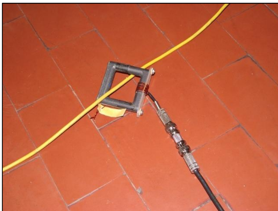
Figura 3.7 - Sensor de corrente instalado no cabo de aterramento do TC (Capelini, 2011).
