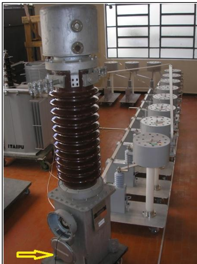
Figura 3.6 - TC conectado à extremidade inicial da linha de transmissão, com o respectivo cabo de aterramento indicado pela seta (Capelini, 2011).
