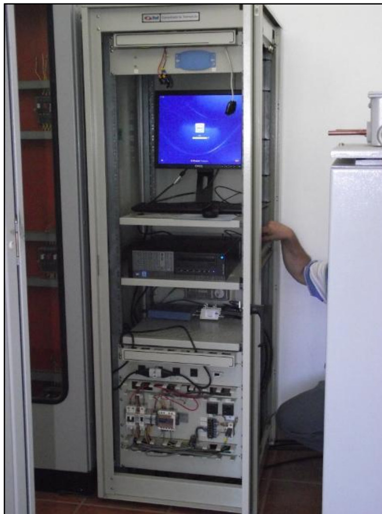
Figura 4.38 - Equipamentos instalados no painel de telemedição da SE São Gabriel.
