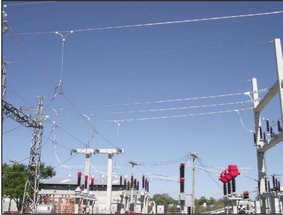
Figura 4.8 - Local pré-selecionado para instalação das bobinas de bloqueio na SE São Gabriel.
