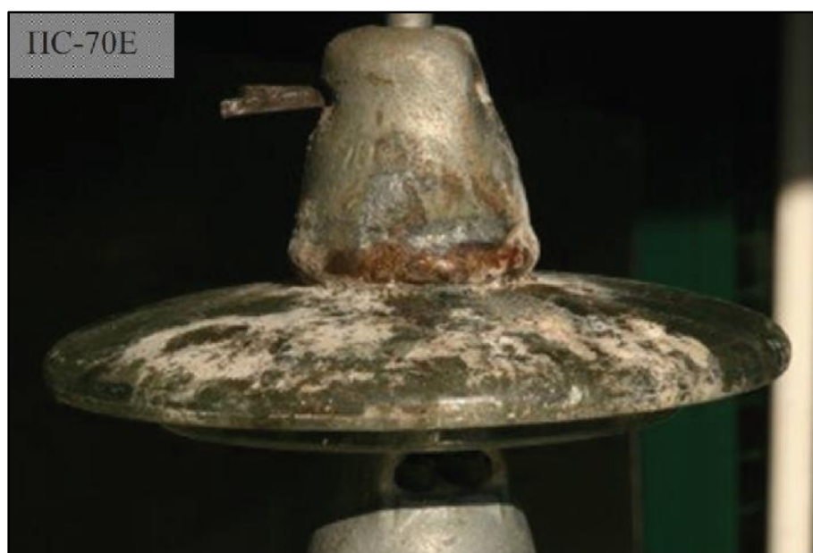
Figura 2.14 - Campânula de isolador de vidro em processo de corrosão devido ao acúmulo de excrementos de pássaros (Taklja; Niitsoo; Palu, 2012).
