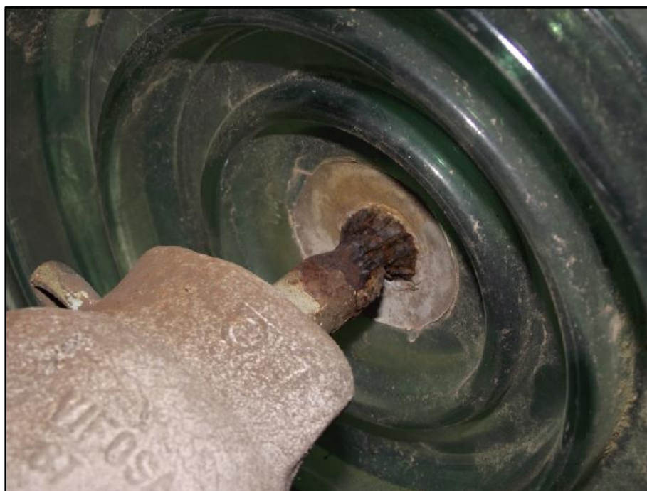
Figura 2.8 - Pino de isolador de disco altamente corroído.
