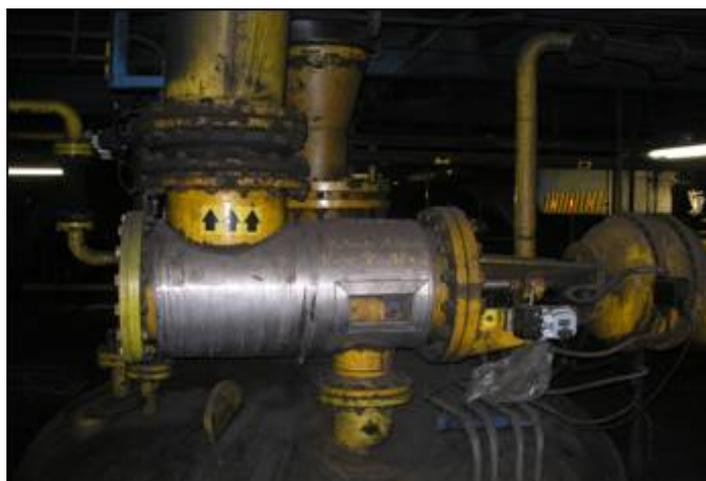
Figura 2.22 - Válvula de alívio do vaso 4 do Alto-forno 3
