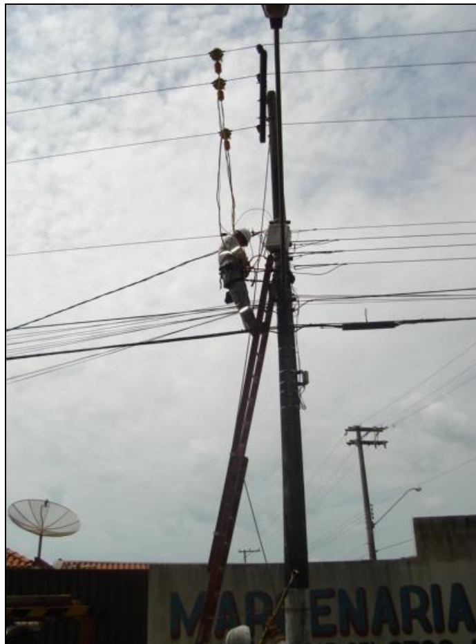
Figura 26: Instalação do medidor Marh-MT no ITC-04, entre a fundição FA e FB (Marginal).
