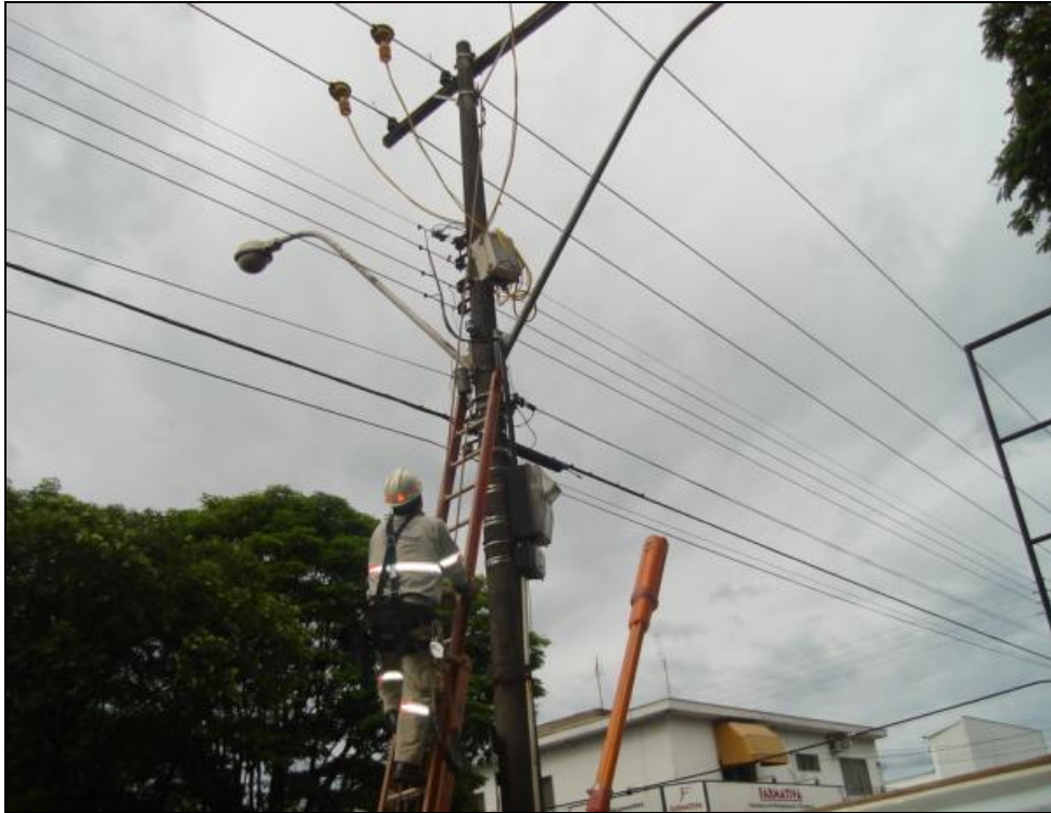
Figura 25: Instalação do medidor Marh-MT no ITC-04, entre os dois primeiros bancos de capacitores BC-1 e BC-2 (Praça).
