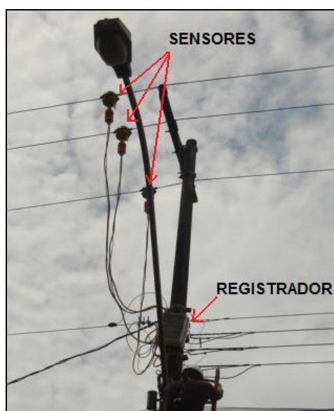
Figura 20: Sensores e Registrador do Marh-MT.
