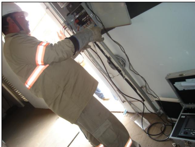
Figura 27: Instalação do medidor Power ION na fundição F A .
